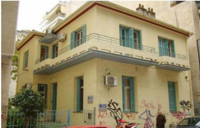
Εικόνα 55: Κτίριο επί της οδού Αθ. Διάκου
