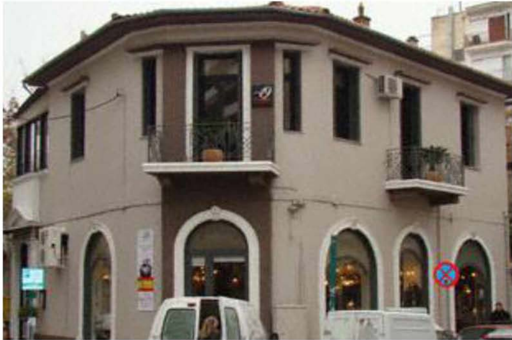
Εικόνα 50: Κτίριο επί της Ηφαίστου & Κενταύρων
