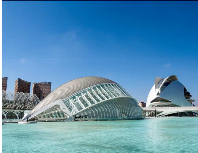
Εικόνα 24: Περιβάλλον χώρος της CASA (Πηγή: http://www.spacesxplaces.com/city-of-arts-and-sciences-
