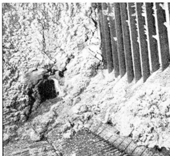
Σχήμα 10 Σχηματισμός επικαθίσεων στα τοιχώματα θαλάμου καύσης (slagging)
