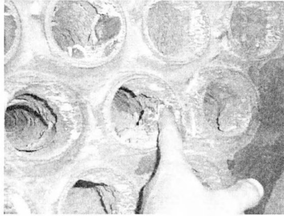
Σχήμα 9 Σχηματισμός επικαθίσεων σε επιφάνειες εναλλαγής με συναγωγή (fouling)
