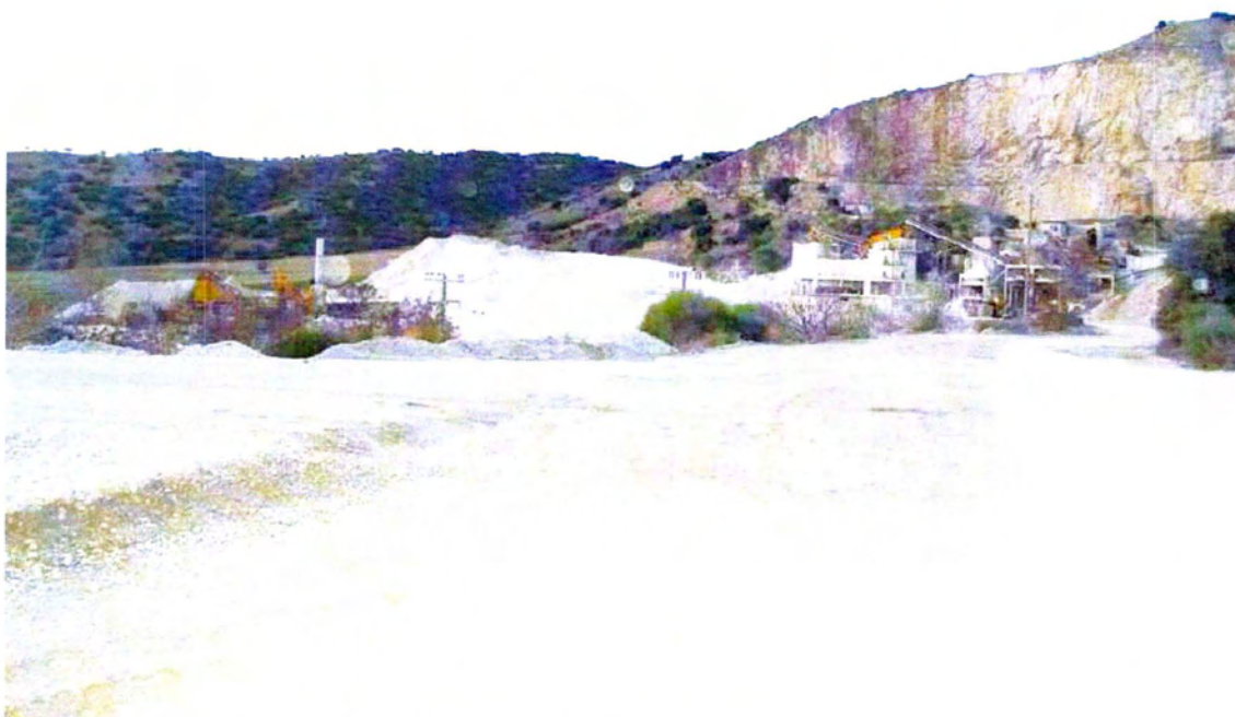
Σχήμα 7.5 Θέση ασφαλτοσυγκροτήματος «ΧΑΤΖΗΓΑΚΗΣ»
