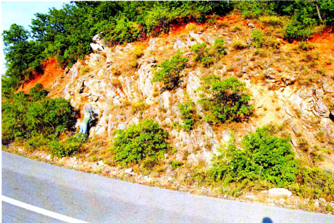
Σχήμα 2.13 Επαφή λεπτοπλακωδών ωολιθικών γκρίζων ασβεστολίθων (Jms.k), με ερυθρούς σχιστοκερατόλιθους (Jim.sh), σε πρανές της υπάρχουσας οδού
