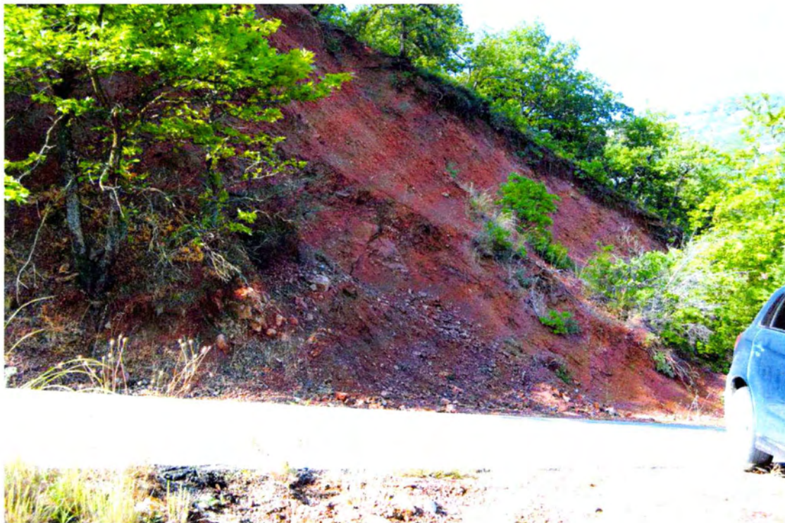
Σχήμα 2.14 Άποψη υφιστάμενου πρανούς συνιστάμενο από ερυθρούς σχιστοκερατόλιθους, ύψους 12μ. και μορφολογικής κλίσης 60% επί της οδού μελέτης
