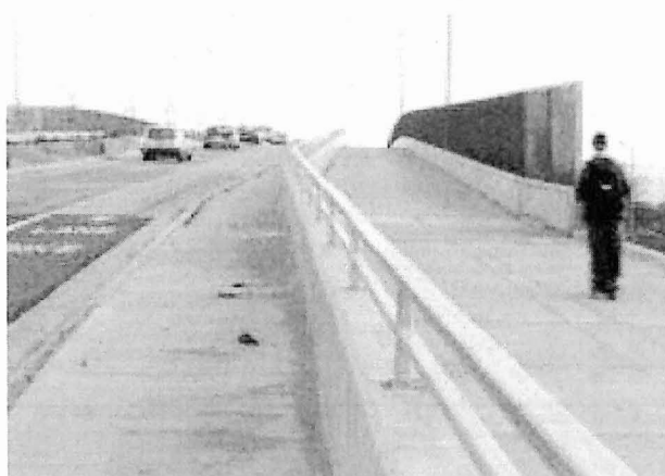
Σχήμα 2.18 Κατασκευή σε εθνική οδό
