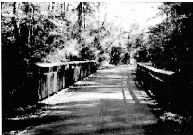
Σχήμα 2.17 Κατασκευή μικρής γέφυρας σε λωρίδα μικτής χρήσης
