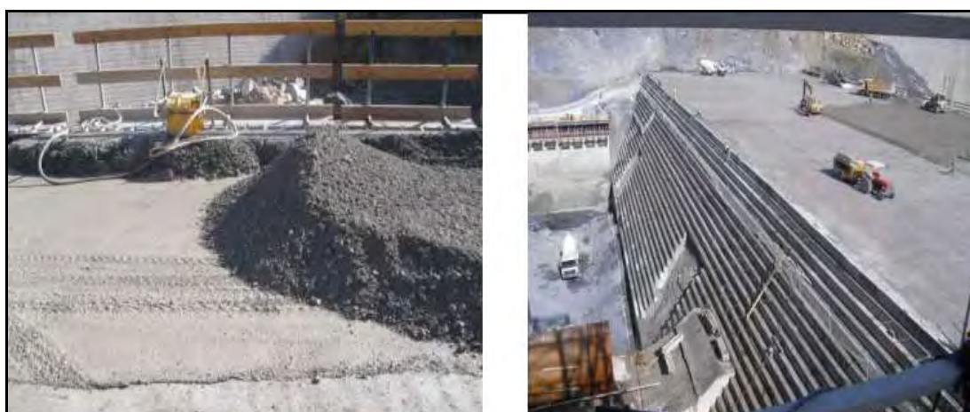
Σχήμα 2. 8 Τοποθέτηση και διάστρωση κυλινδρούμενου σκυροδέματος σε στρώσεις.
