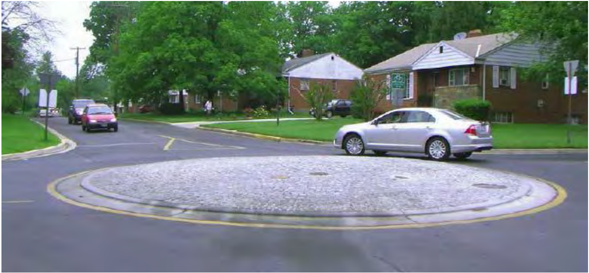
Κομβίδιο κυκλικής κίνησης σε υφιστάμενη διασταύρωση με υπερυψωμένη κεντρική νησίδα
