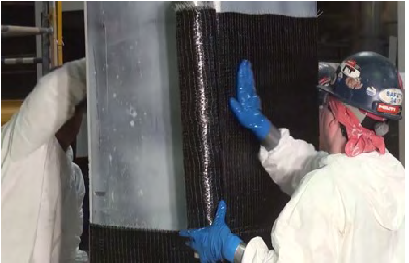
Σχ. 1.9.4 Ενίσχυση υποστυλώματος με FRP
