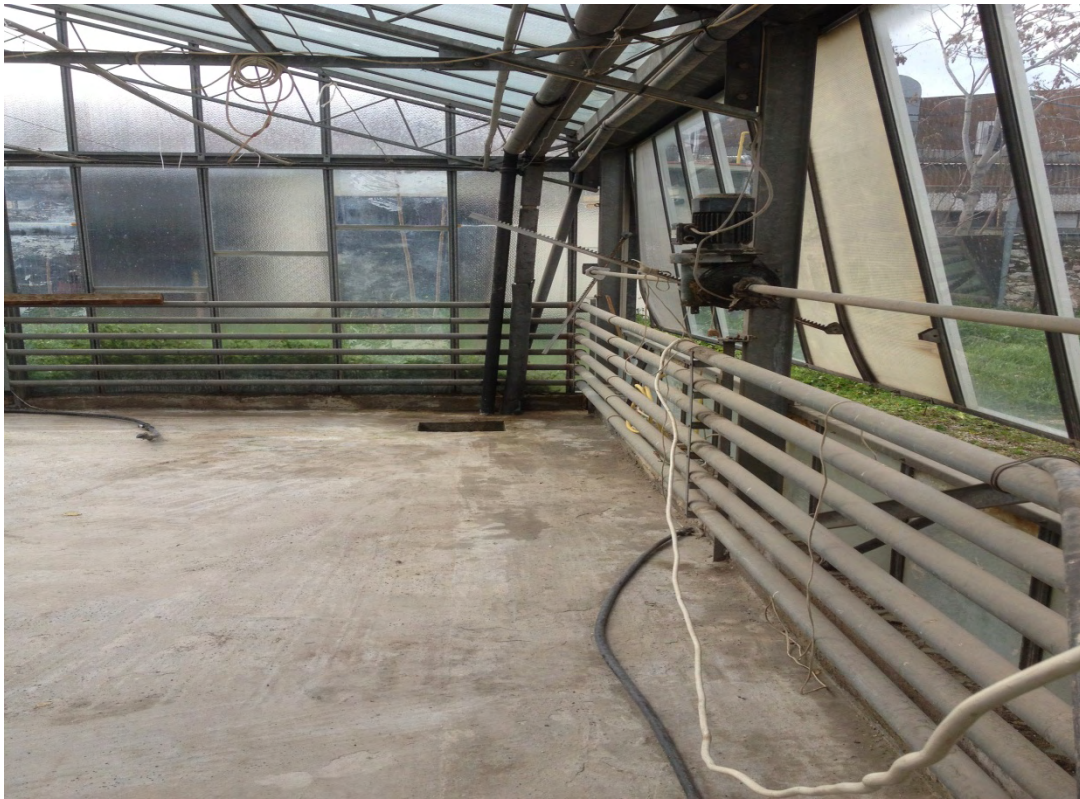
Εικόνα 2.2 Δυτική πλαϊνή πλευρά αερισμού θερμοκηπίου ΓΠΑ
