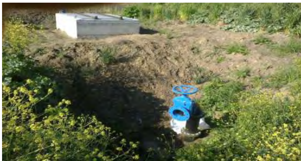
Εικόνα 4.13 βάνα ελεύθερης εκροής 2
