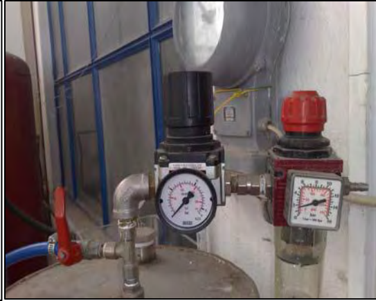
Εικόνα 2.2. Ρυθμιστής πίεσης στο θερμοσίφωνα
