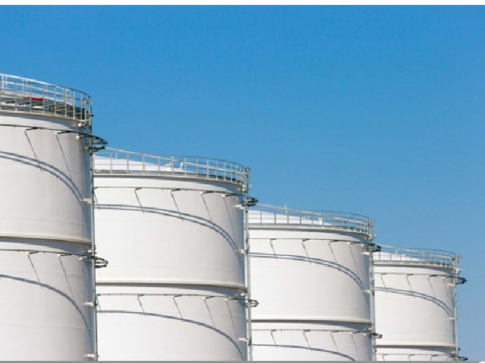
Εικόνα 8.1. 1 Δεξαμενές πετρελαίου με οριζόντιους δακτυλίους
