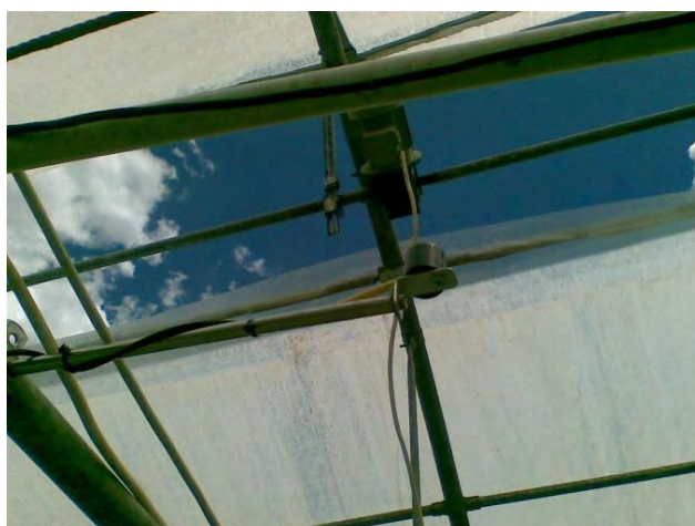
Εικόνα 3.3. Αισθητήρας μέτρησης Ηλιακής Ακτινοβολίας
