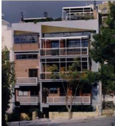
Εικόνα 21: Διαμέρισμα στο Αττικό Άλσος
