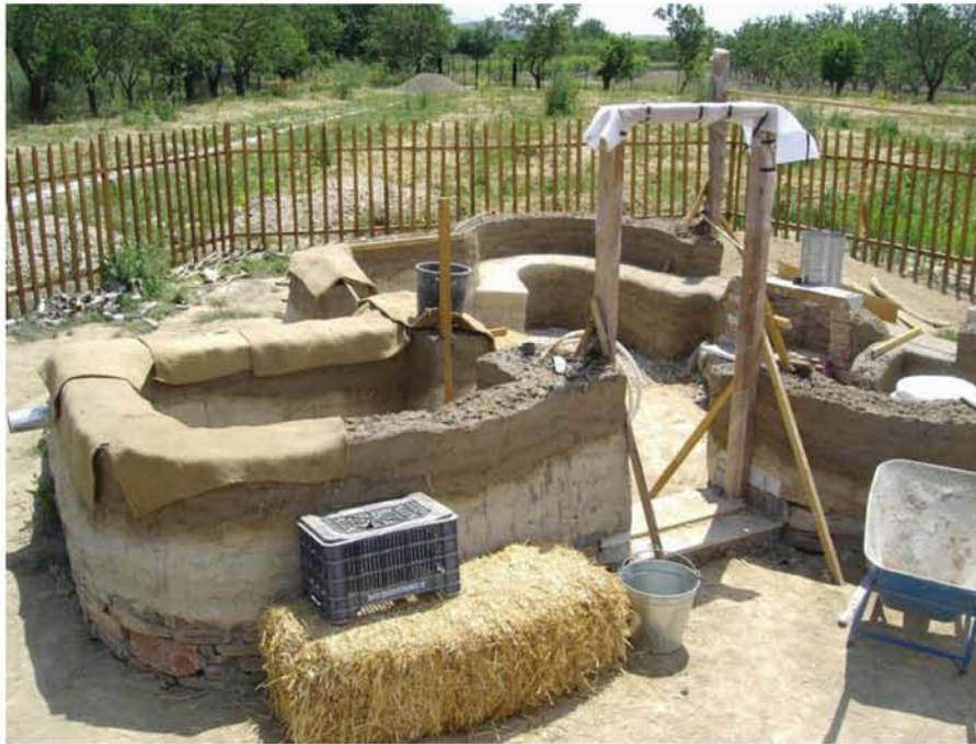
Εικόνα 52: Cob υπό κατασκευή
