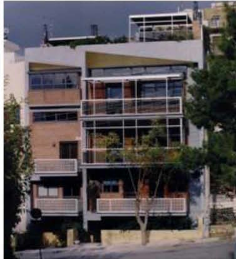
Εικόνα 21: Διαμέρισμα στο Αττικό Άλσος
