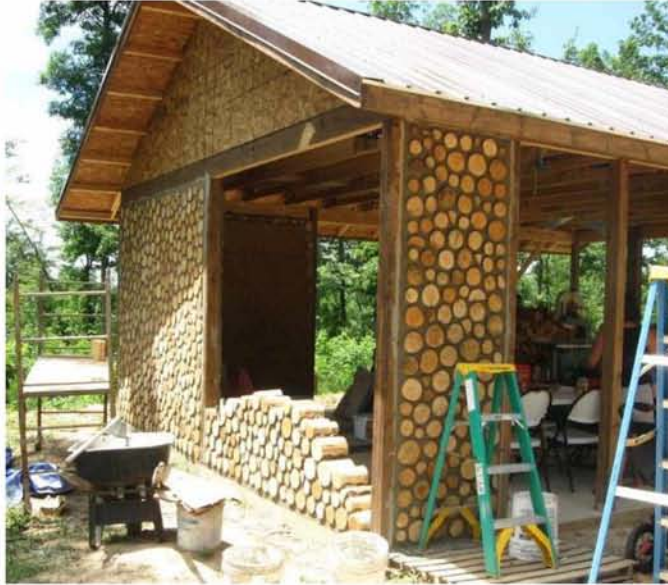
Εικόνα 58: Cordwood κατασκευή
