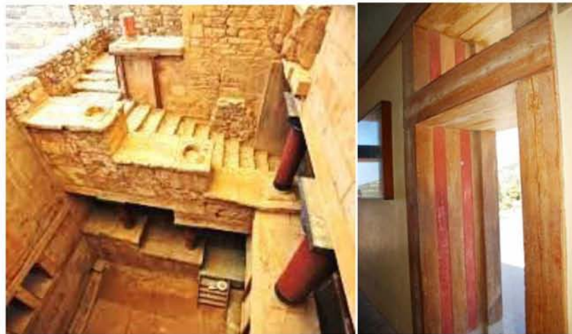
Εικόνα 4: Κνωσός, α. Κεντρικό κλιμακοστάσιο με κλιμακωτά στηθαία και κίονες, β. Λεπτομέρεια λιθόκτιστης κατασκευής σε συνδυασμό με ξύλινο σκελετό. Εδώ, στην αποκατάσταση Έβανς, το ξύλο αντικαθίσταται από μπετόν. Πηγή: Προσωπικό αρχείο.
