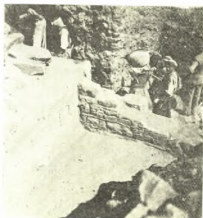
Εἰκ. 7. Ὁ τοίχος Β καὶ ἡ μετὰ τοῦτον προέκτασις τοῦ τοίχου Σ.
