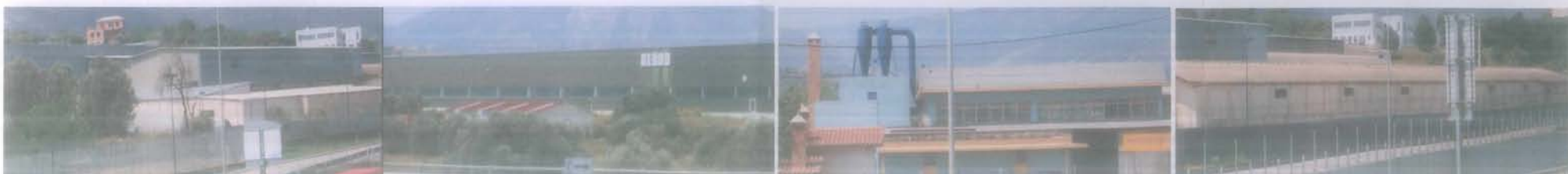
Εικόνες 5,6,7,8,9,10,11,12,13,14,15 & 16 Η εμφάνιση διάσπαρτων κτισμάτων για την εξυπηρέτηση του χονδρεμπορίου της βιομηχανίας-βιοτεχνίας (εκτός των εγκεκριμένων για αυτή τη χρήση περιοχών) Πηγή Φωτογραφιών: Προσωπικό Αρχείο.
