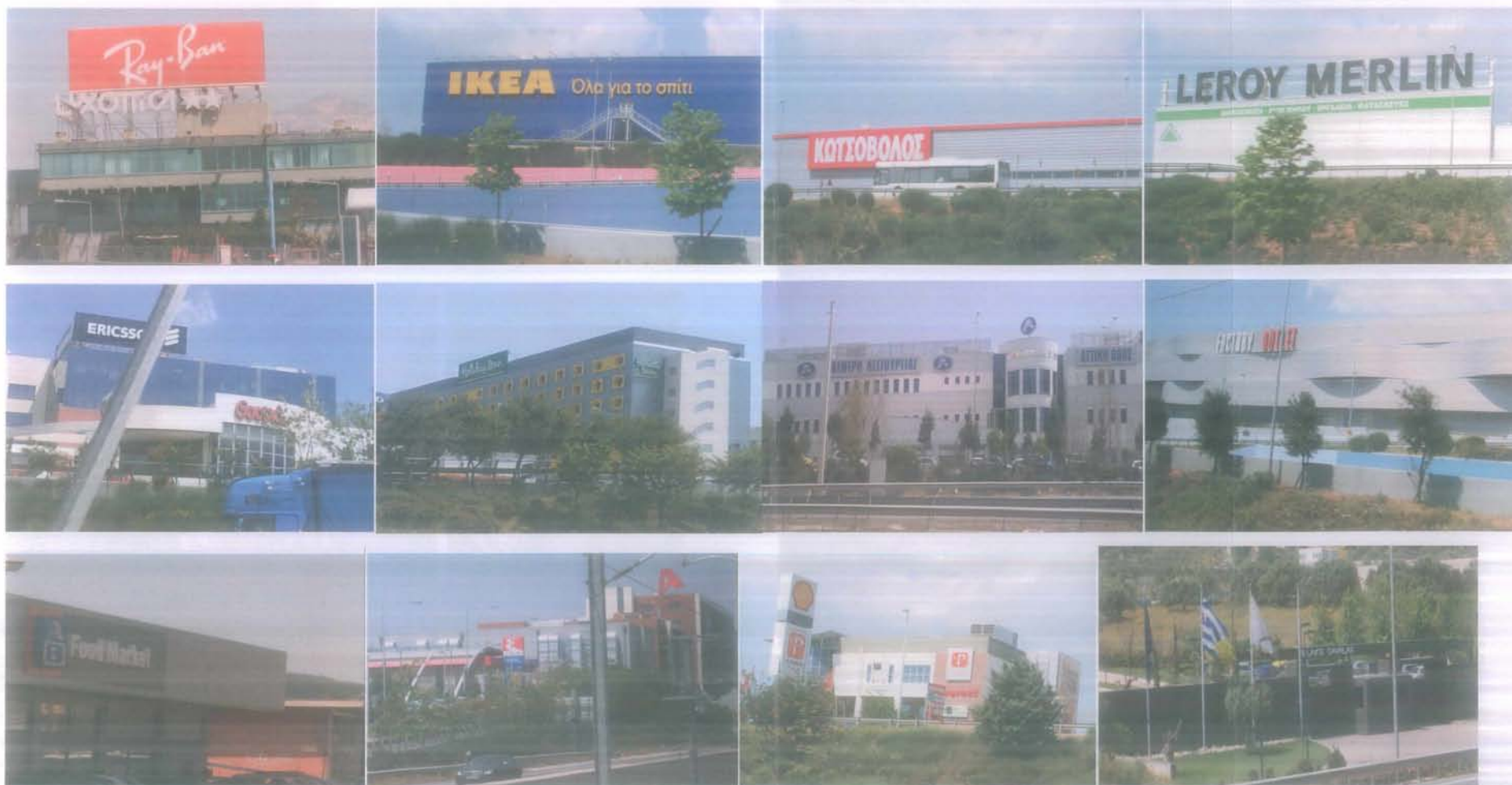
Εικόνες 17 έως 28: Η Παρόδια Περιοχή της Αττικής Οδού ως υποδοχέας οικονομικών δραστηριοτήτων εμπορικού τύπου (IKEA, Κατσόβολος, Factory Outlet, κ.α.) αλλά και οικονομικών δραστηριοτήτων αστικού τύπου (τηλεοπτικός σταθμός Αλφα, ξενοδοχείο Holiday Inn, γραφεία Αττικής Οδού κ.α.) Πηγή Φωτογραφιών: Προσωπικό Αρχείο.
