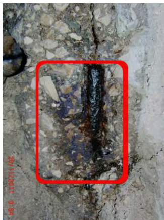
Σχήμα 2-7: Ψεκάσμος σκυροδέματος με διάλυμα \text{AgNO}_3 (Σιδέρης, Δομικοί Έλεγχοι)
