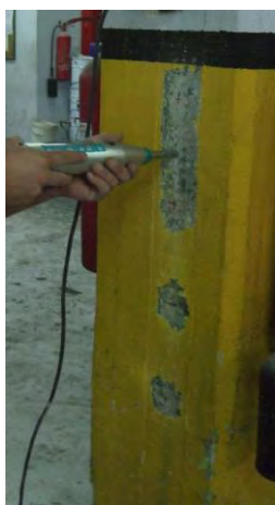
Σχήμα 2-1: Κρουσιμέτρηση σε υποστύλωμα (Σιδέρης,, Δομικοί Έλεγχοι)
