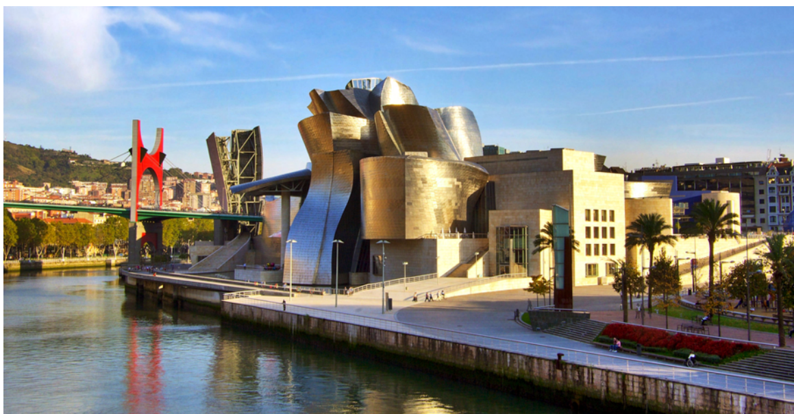
Εικόνα 32. Το Μουσείο του οργανισμού Guggenheim στο Μπιλμπάο της Ισπανίας από τον διεθνή φήμης αρχιτέκτονα Frank Gehry, το οποίο ολοκληρώθηκε το 1997.
