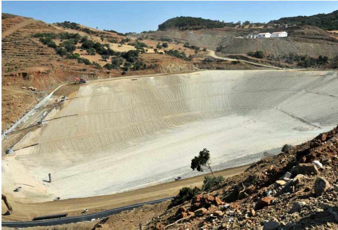
Εικόνα 7: ΧΥΤΑ Φλόκα στο Νομό Αχαΐας Πηγή : www.patratona.gr
