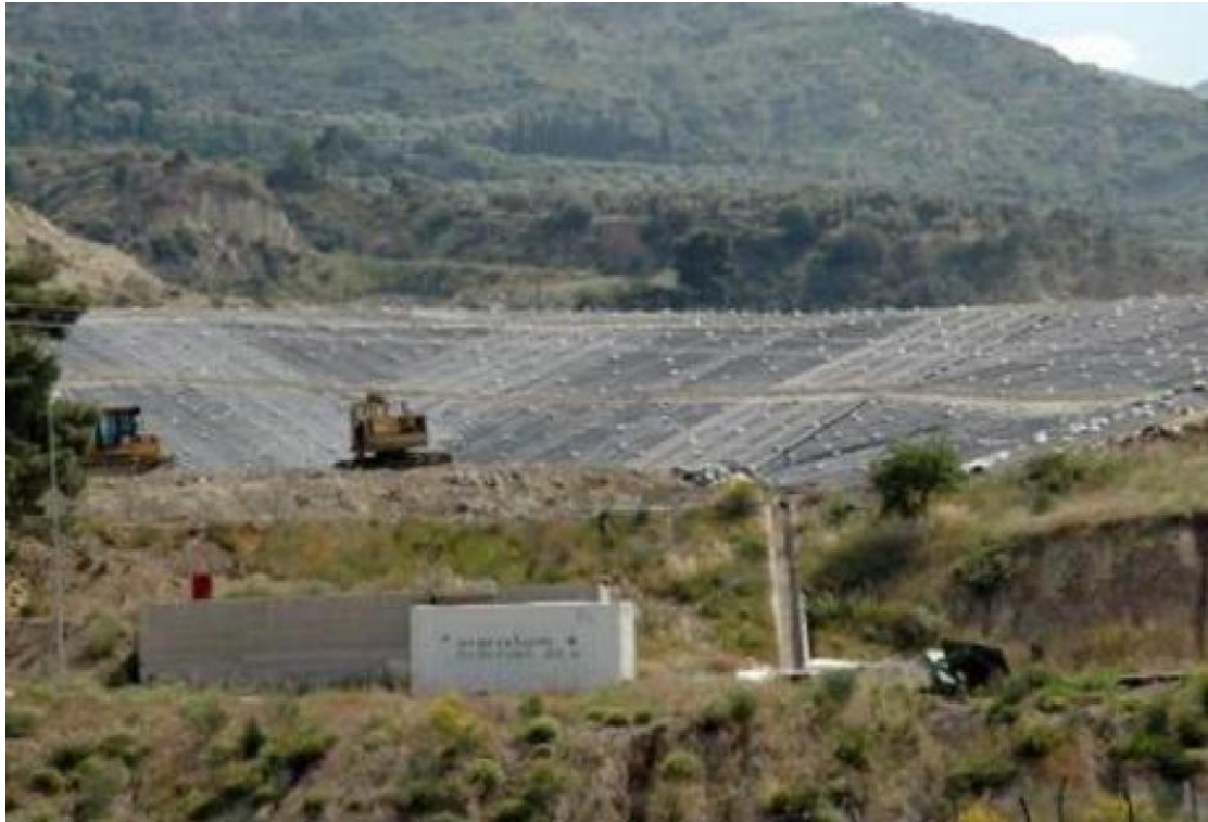
Εικόνα 1 : ΧΥΤΑ Φλόκα στο Νομό Αχαΐας. Πηγή : www.patratona.gr
