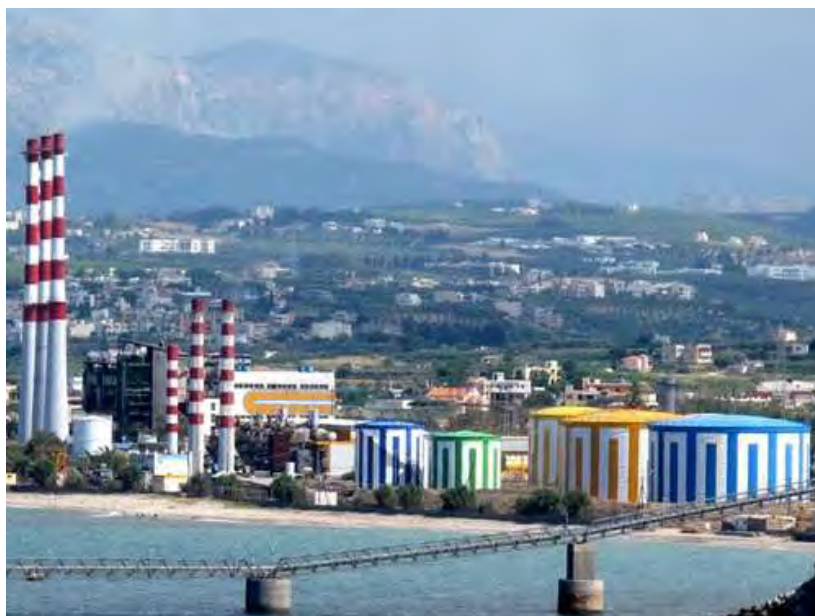
Εικόνα 8: Ατμοηλεκτρικός Σταθμός παραγωγής ηλεκτρικής ενέργειας
