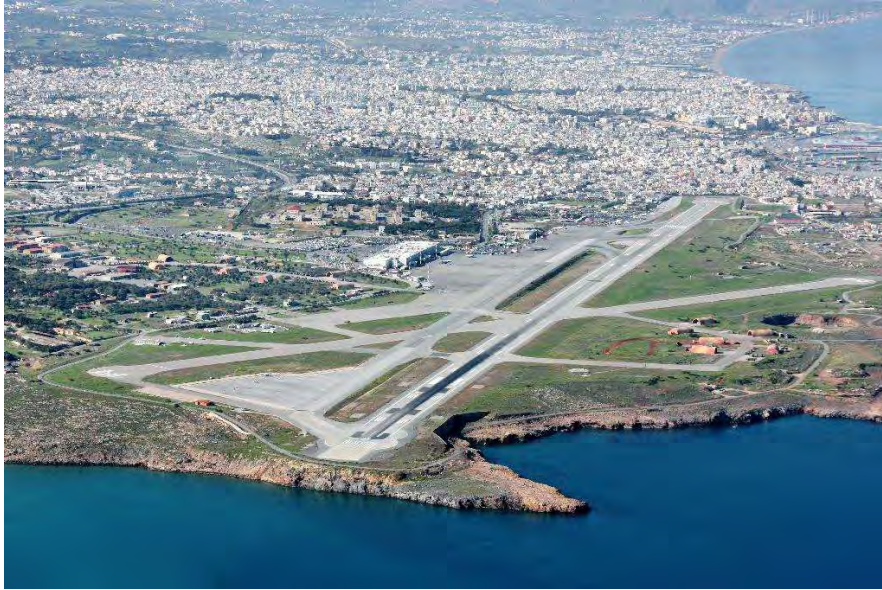
Εικόνα 10: Διεθνής Αερολιμένας Ηρακλείου, «Νίκος Καζαντζάκης»
