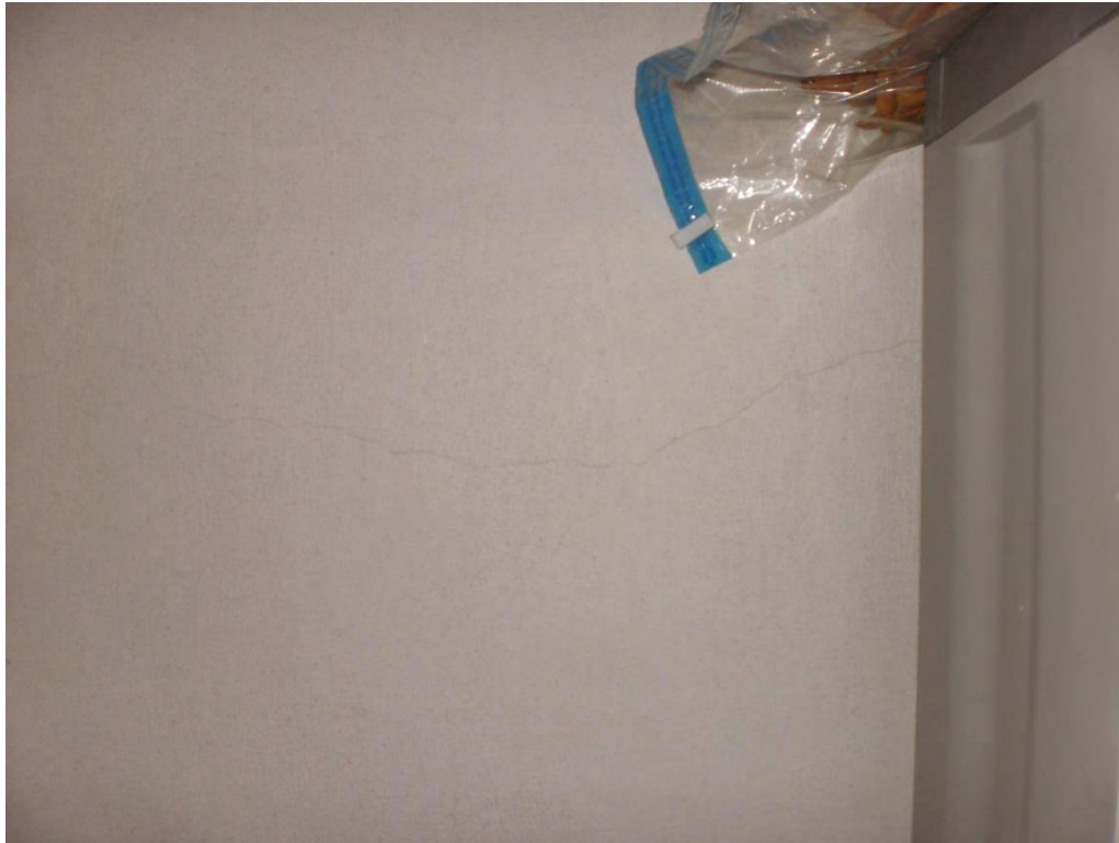
Εικόνα 75: Δυτικός τοίχος στο wc όπου έγινε μέτρηση υγρασίας.
