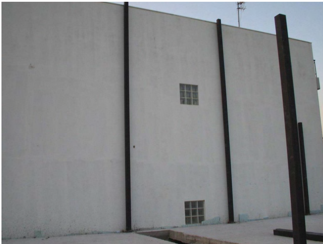
Εικόνα 40: Φωτογραφία της βόρειας πλευράς της οικίας η οποία είναι μεσοτοιχία με παρακείμενη οικία.
