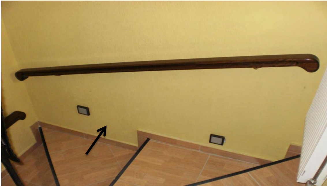
Εικόνα 91: Φωτογραφία του δυτικού τοίχου του κλιμακοστασίου όπου έχει επισημανθεί η περιοχή όπου βρίσκεται το μεσοχώρισμα των δυο ορόφων.
