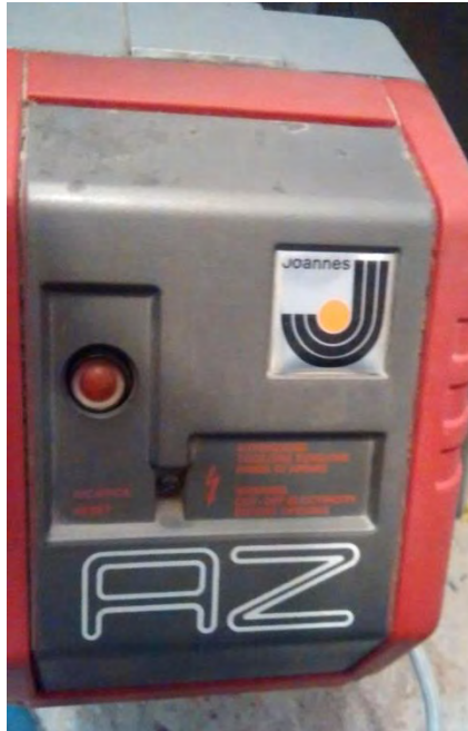
Εικόνα 45: Φωτογραφία του καυστήρα πετρελαίου.
