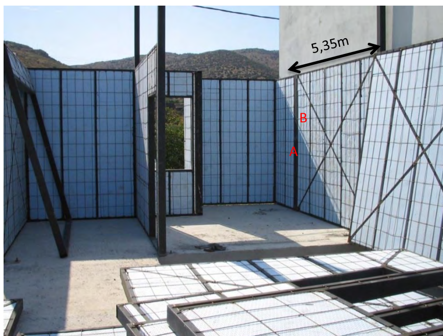
Εικόνα 107: Φωτογραφία της τοιχοποιίας της οικίας όπου διακρίνεται ο διαχωρισμός των τμημάτων με μήκος 5,35m σε μικρότερα επιμέρους τμήματα ενώ έχουν επισημανθεί και οι περιοχές Α και Β για τον υπολογισμό του σύνθετου συντελεστή θερμοπερατότητας.
