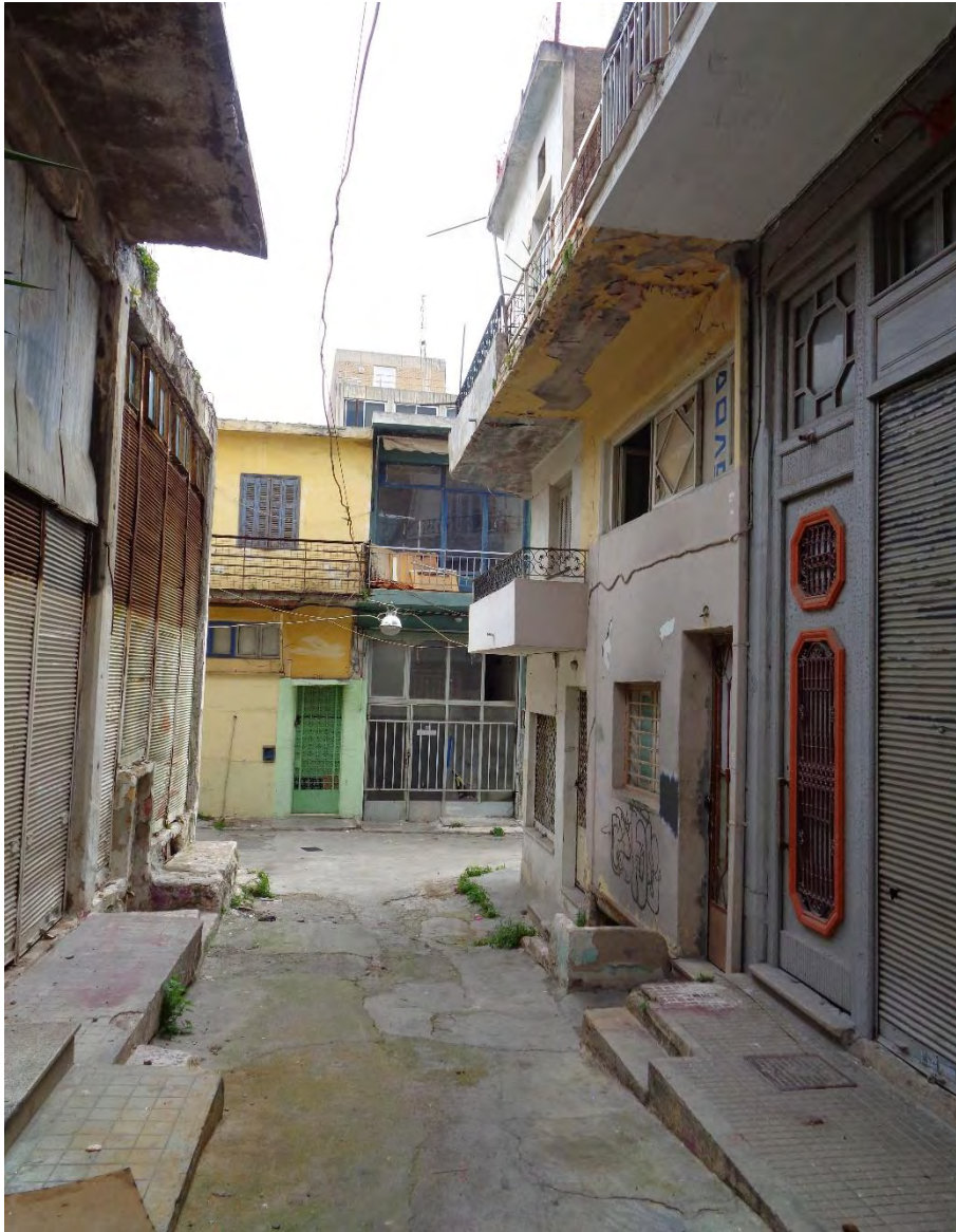
Εικόνα 11 Σύγχρονη άποψη Λαμαρινάδικων (προσωπικό αρχείο)
