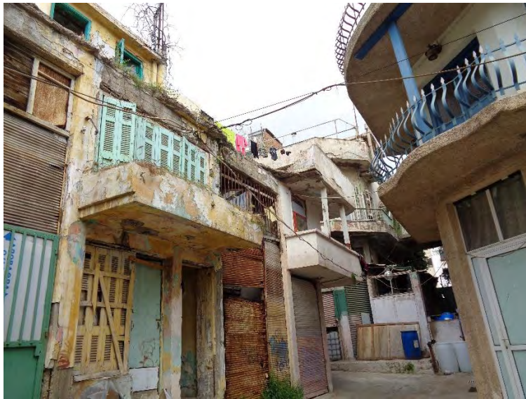
Εικόνα 12 Σύγχρονη άποψη Λαμαρινάδικων (προσωπικό αρχείο)
