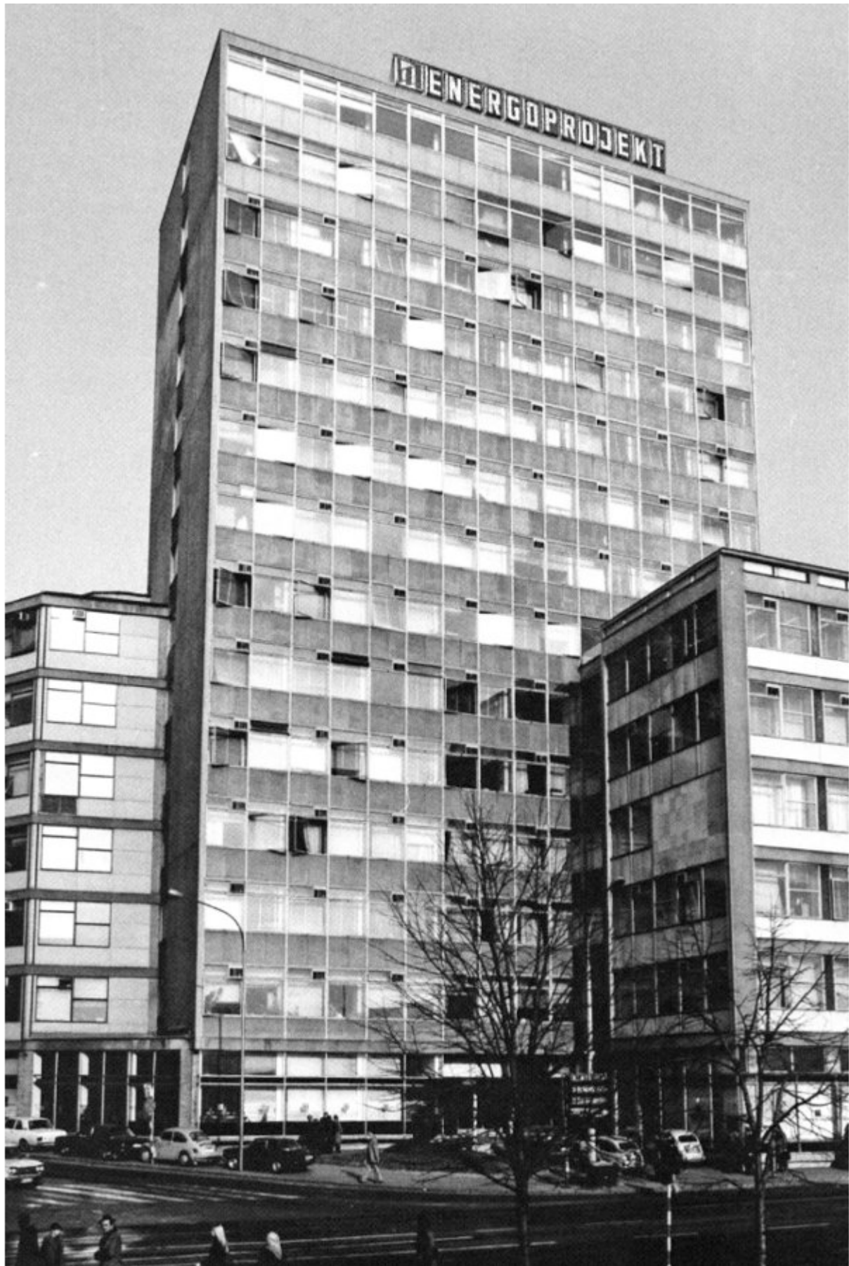
φωτογραφία από την απέναντι πλευρά της οδού Βραγκοβα πηγή: http://www.cab.rs/en/blog/alfa-i-omega-arhitekture-energoprojekta# .
