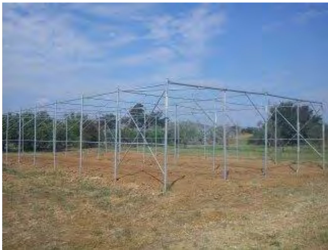
Εικόνα 14. Η μεταλλικόςκελετός του διχτυοκηπίου.
