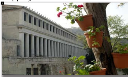
Εικόνα 3.21. Εξωτερική άποψη της Στοάς του Αττάλου όπου στεγάζεται το Μουσείο της Αρχαίας Αγοράς (φωτογραφία από το αρχείο της ερευνήτριας)
