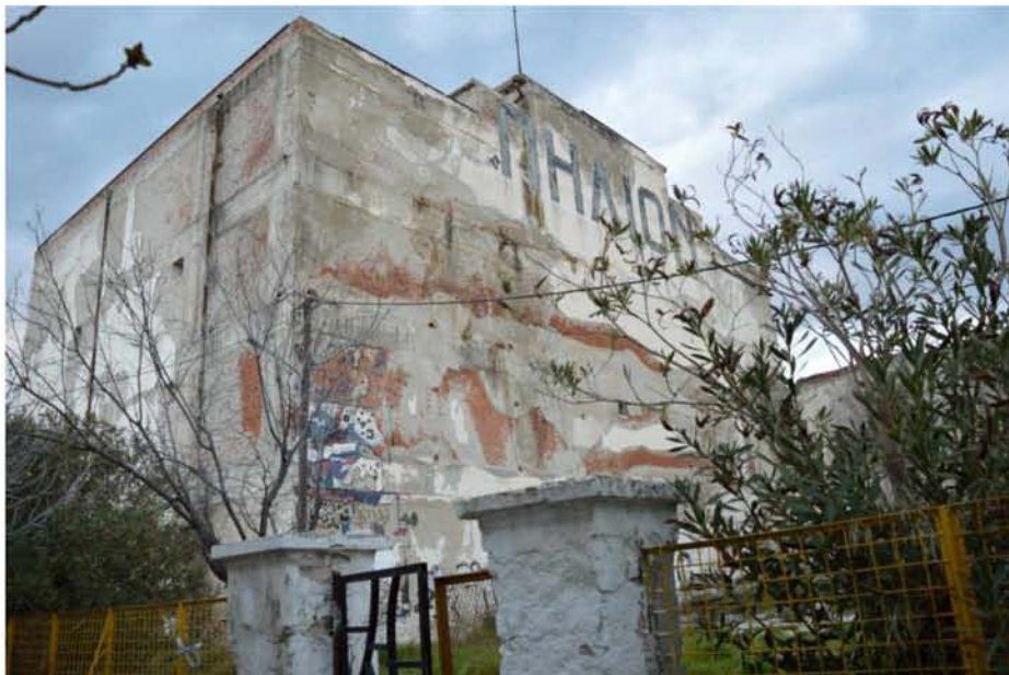
Εικόνα 2.21: Το εγκαταλελειμμένο κτίριο των «Ψυγείων Μουστακαλή»
