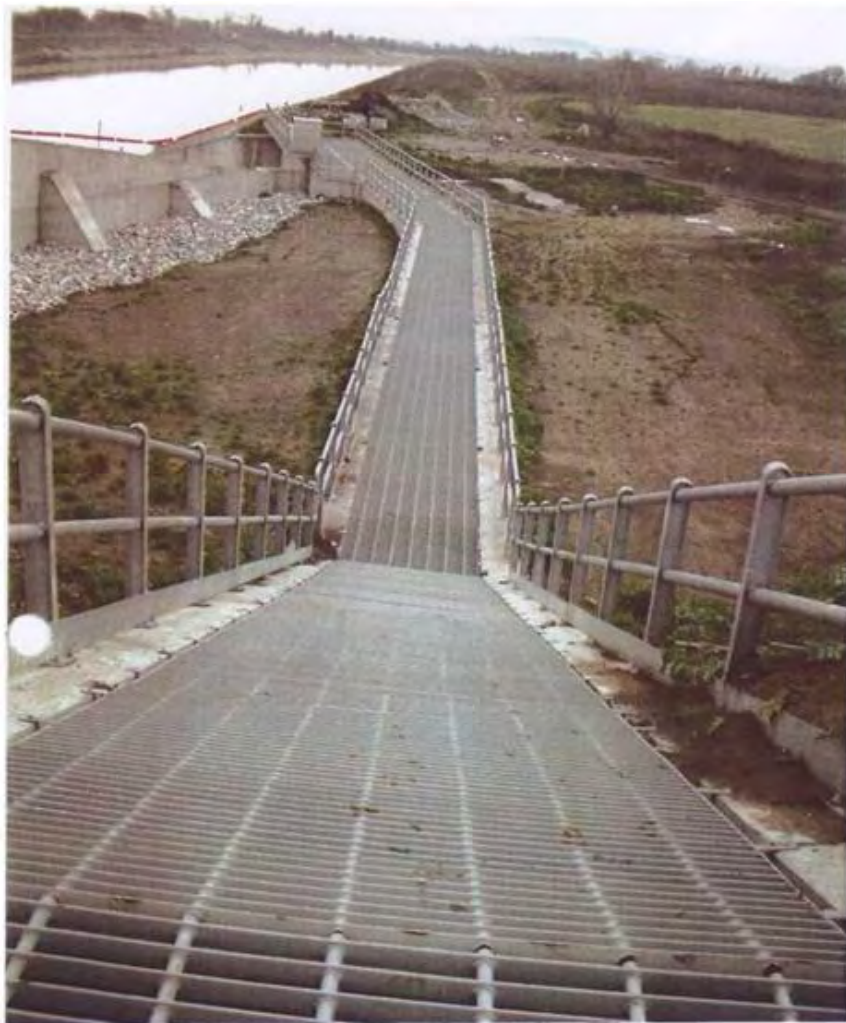
ΦΩΤ.10 ΑΠΟΨΗ ΔΙΟΔΟΥ ΙΧΘΥΩΝ (ΑΝΑΝΤΗ ΤΜΗΜΑ)
