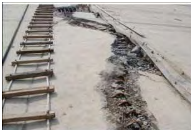
Σχήμα 5 ΘΡΑΥΞΗ ΣΚΥΡΟΔΕΜΑΤΟΣ ΛΟΓΩ ΘΛΙΨΗΣ ΣΤΟΥΣ ΚΑΤΑΚΟΡΥΦΟΥΣ ΑΡΜΟΥΣ ΤΗΣ ΑΝΑΝΤΗ ΠΛΑΚΑΣ (WIELAND 2009)
