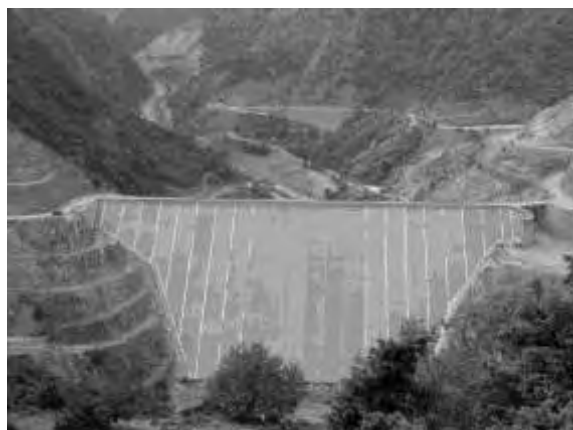
Σχήμα 1 ΑΝΑΝΤΗ ΠΛΑΚΑ ΦΡΑΓΜΑΤΟΣ ΜΕΣΟΧΩΡΑΣ
