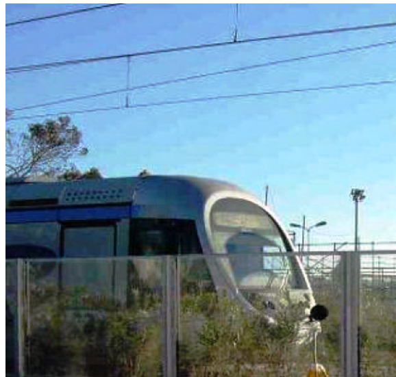
Εικόνα 75: Διαφανές αντιθορυβικό πέτασμα μεσαίου ύψους στην οδό Διαδόχου Παύλου, Γλυφάδα Αττικής Πηγή: Κ. Βογιατζής (2007)
