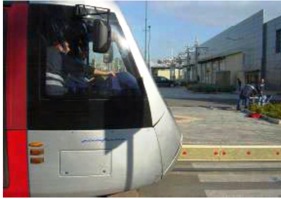
Εικόνα 74: Ηχοαπορροφητικό αντιθορυβικό πέτασμα χαμηλού ύψους (32 cm) στο Αμαξοστάσιο της TRAM Α.Ε. στο Ελληνικό Πηγή: Κ. Βογιατζής (2007)
