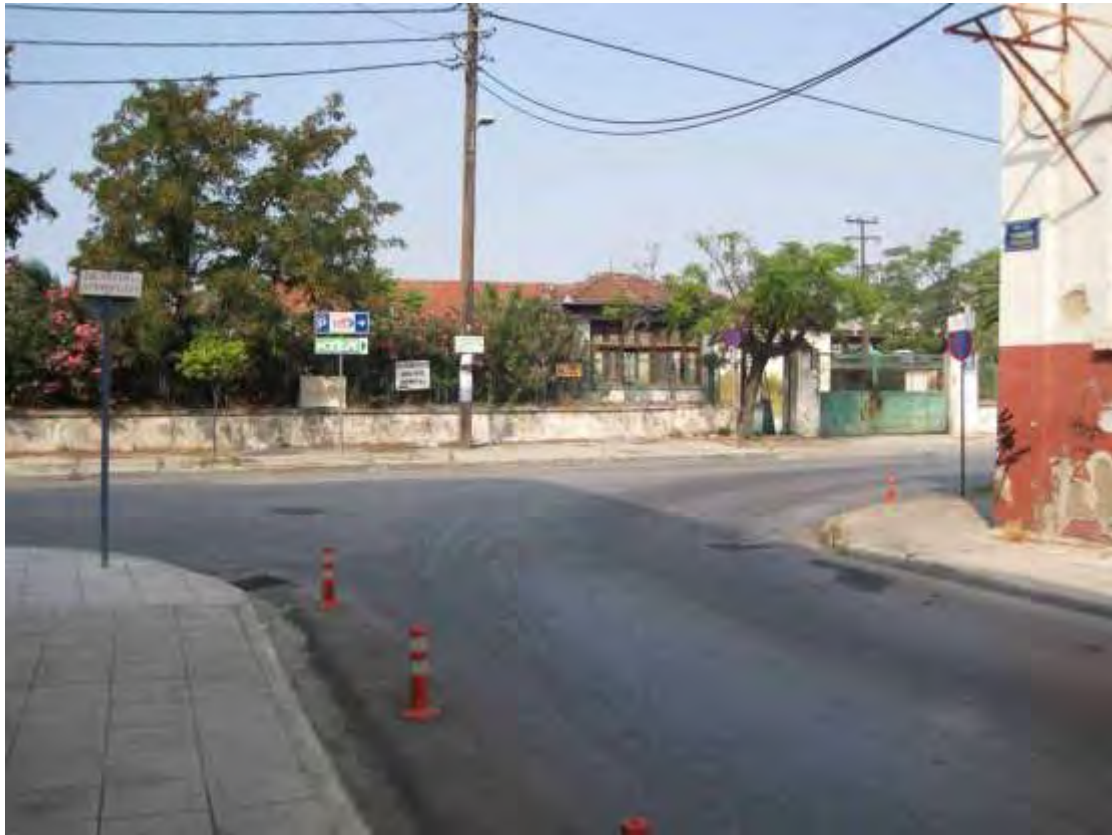
Εικόνα 7.1.3: Διασταύρωση οδών Πυρασσού – Λαχανά, έλλειψη φωτισμού, ικανοποιητική ορατότητα εισερχόμενων οχημάτων
