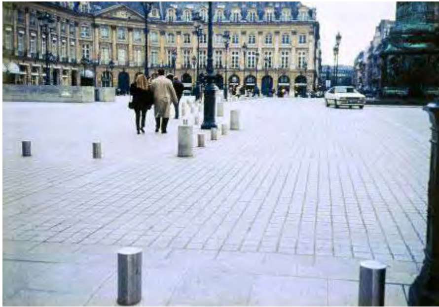
Εικόνα 2.6: Γαλλία. Διαμόρφωση πλατείας σε ενιαία στάθμη. Ο διάδρομος διέλευσης των αυτοκινήτων οριοθετείται μεταλλικούς πασσάλους
