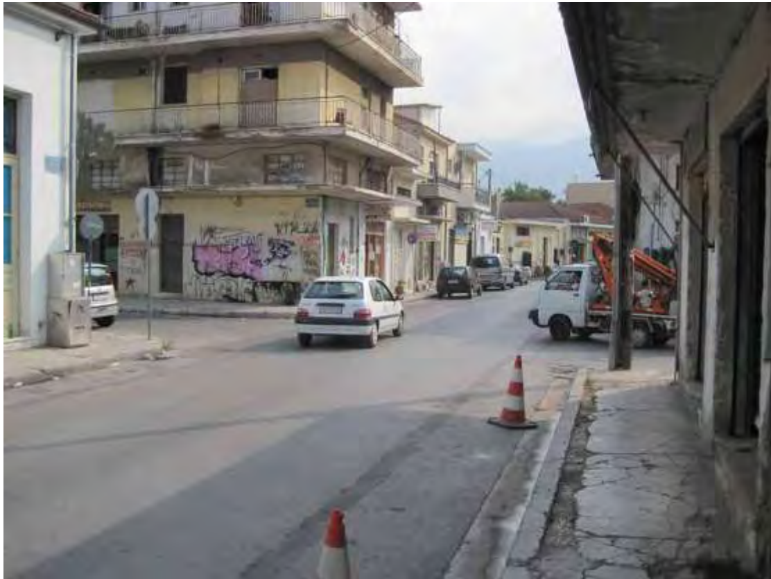
Εικόνα 7.1.6: Διασταύρωση Αλμυρού – Μητ. Γρηγορίου, Χαμηλή ορατότητα εισερχόμενων οχημάτων, έλλειψη φωτισμού
