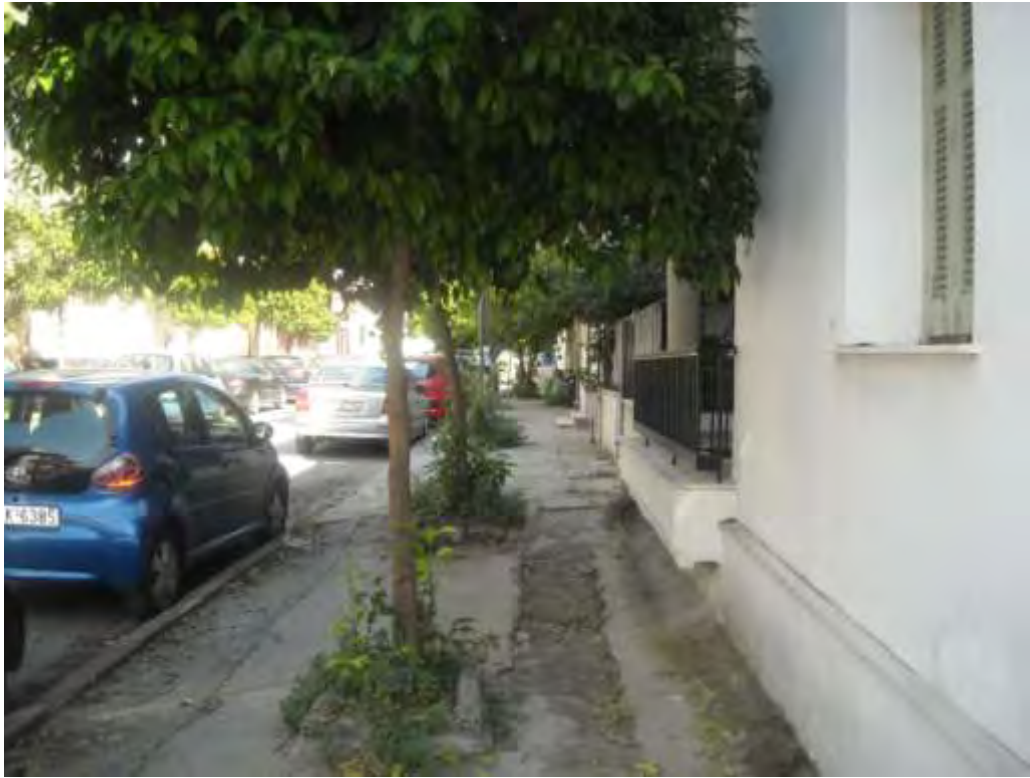
Εικόνα 7.2.9: Κακή ποιότητα του οδοστρώματος του πεζοδρομίου στην οδό Αθ. Διάκου
