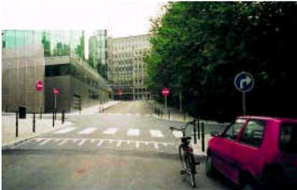
Εικόνα 2.5: Ανύψωση της στάθμης της διασταύρωσης στο ύψος του πεζοδρομίου
