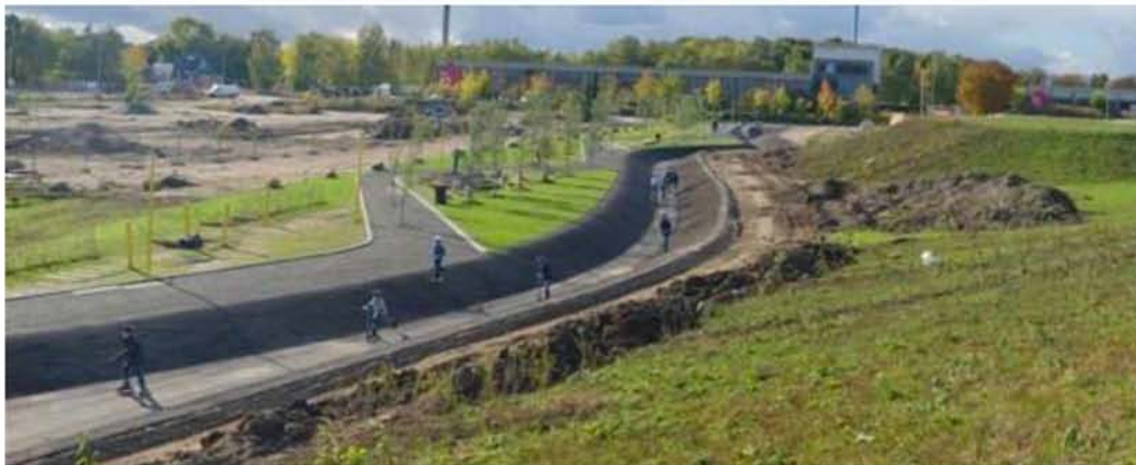
Εικόνες 3.3.42: Πίστα σκέιτ που λειτουργεί και ως δεξαμενή συλλογής βρόχινων υδάτων στο Ροσκίλντε της Δανίας Πηγή: http://www.dac.dk/en/dac-cities/sustainable-cities/all-cases/water/roskilde-storm-water-skate-park/
