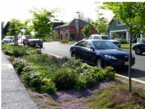
Εικόνα 3.3.45: Φυτεμένοι τάφροι που συλλέγουν και απορροφούν τα βρόχυνα ύδατα. Πηγή: http://water.epa.gov/infrastructure/greeninfrastructure/gi_what.cfm#bioswales
