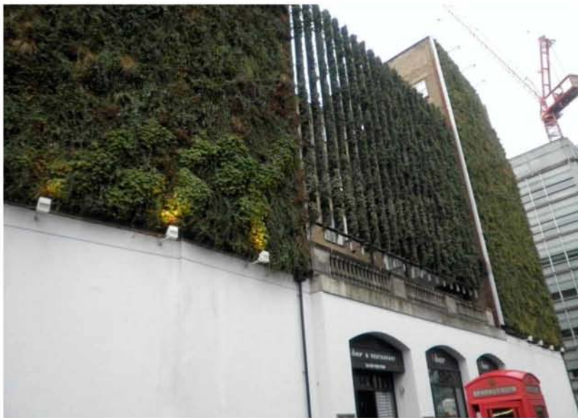
Εικόνα 3.3.29: Πράσινη επιφάνεια κτιρίου στο Λονδίνο. Πηγή: προσωπικό αρχείο
