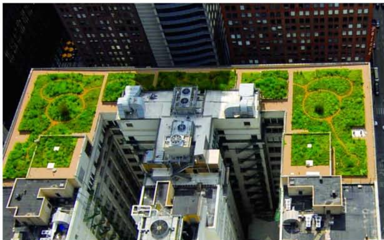
Εικόνα 3.3.26: Πράσινη στέγη στο δημαρχείο του Σικάγο.
