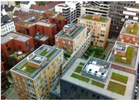
Εικόνα 3.3.27: Πράσινες στέγες σε πολυκατοικίες. Πηγή: http://b-i.forbesimg.com/houzz/files/2013/12/home-design.jpg
