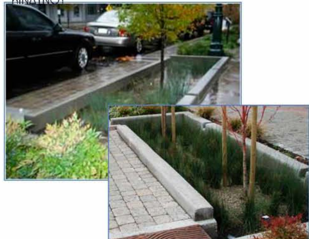
Εικόνες 3.3.46: Φυτεμένοι χώροι με βάθος δίπλα στο πεζοδρόμιο – συνδεδεμένοι με την αποχέτευση. Συλλέγουν και απορροφούν τα βρόχυνα ύδατα. Πηγή: http://water.epa.gov/infrastructure/greeninfrastructure/gi_what.cfm#bioswales , http://www.phillywatersheds.org/what_were_doing/green_infrastructure/tools/stormwater-planter
