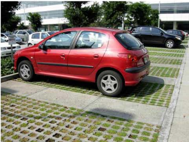
Εικόνα 3.3.44: Πορώδες έδαφος σε χώρο στάθμευσης για την καλύτερη απορρόφηση των βρόχινων υδάτων. Πηγή: Matthews, T. (2011), Climate Change Adaptation in Urban Systems: Strategies for Planning Regimes, Urban Research Program-Research Paper 32, Griffith University
