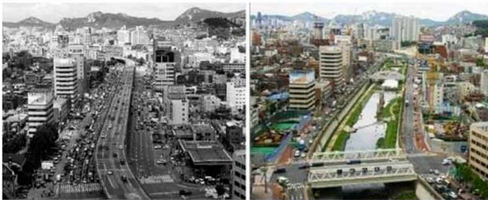
Εικόνα 3.3.32: Παράδειγμα αποκατάστασης ποταμού Cheonggyecheon στη Σεούλ - διάνοιξη της υπογειοποιημένης επιφάνειας του ποταμού και διαμόρφωση γραμμικού πάρκου.
