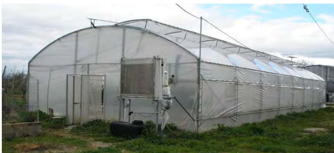
Εικόνα 30 Πλαστικό θερμοκήπιο Εργαστηρίου Γ. Κατασκευών & Ελέγχου Περιβάλλοντος του ΠΘ
