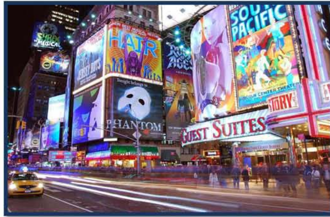
Εικόνα 4.6: Διαφημιστικές πινακίδες τοποθετημένες στις όψεις κτηρίων
