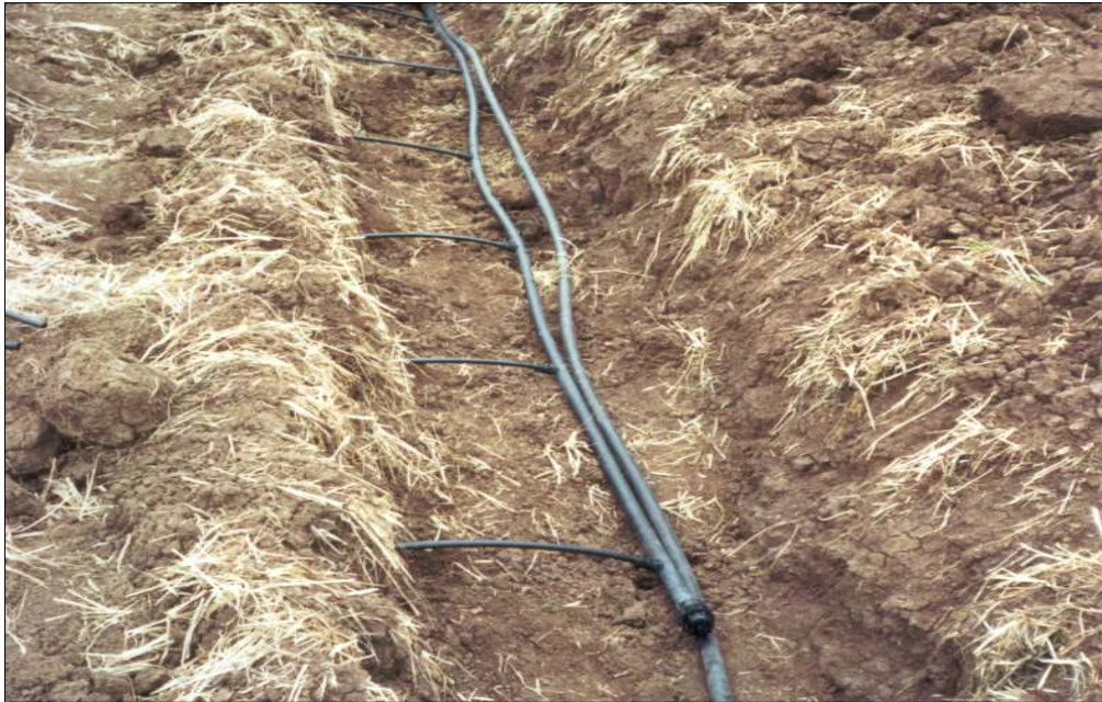
Εικόνα 8. Εγκατάσταση συστήματος υπόγειας στάγδην άρδευσης.
