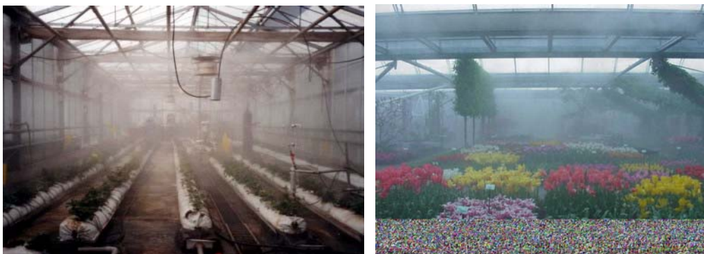
Εικόνα 2.6. Σύστημα τεχνητής ομίχλης.
