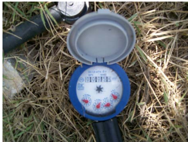
Εικόνα 5.10 Υδρόμετρο
