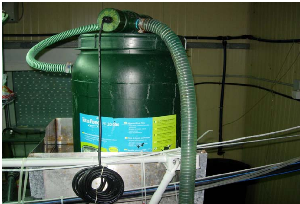
Εικόνα 5. Το μηχανικό, χημικό και βιολογικό φίλτρο.
