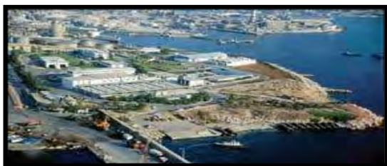
Πηγή: Φωτογραφικό υλικό Ε.Υ.Δ.Α.Π. (2007) Εικόνα 2.8 Εγκαταστάσεις Ακροκεράμου
