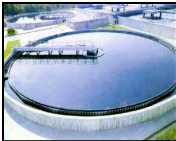
Εικόνα 1.9: Εγκαταστάσεις δευτεροβάθμιας επεξεργασίας (Βιολογικός καθαρισμός)
