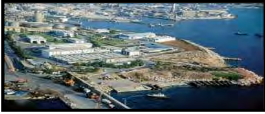
Πηγή: Φωτογραφικό υλικό Ε.Υ.Δ.Α.Π. (2007) Εικόνα 2.8 Εγκαταστάσεις Ακροκεράμου
