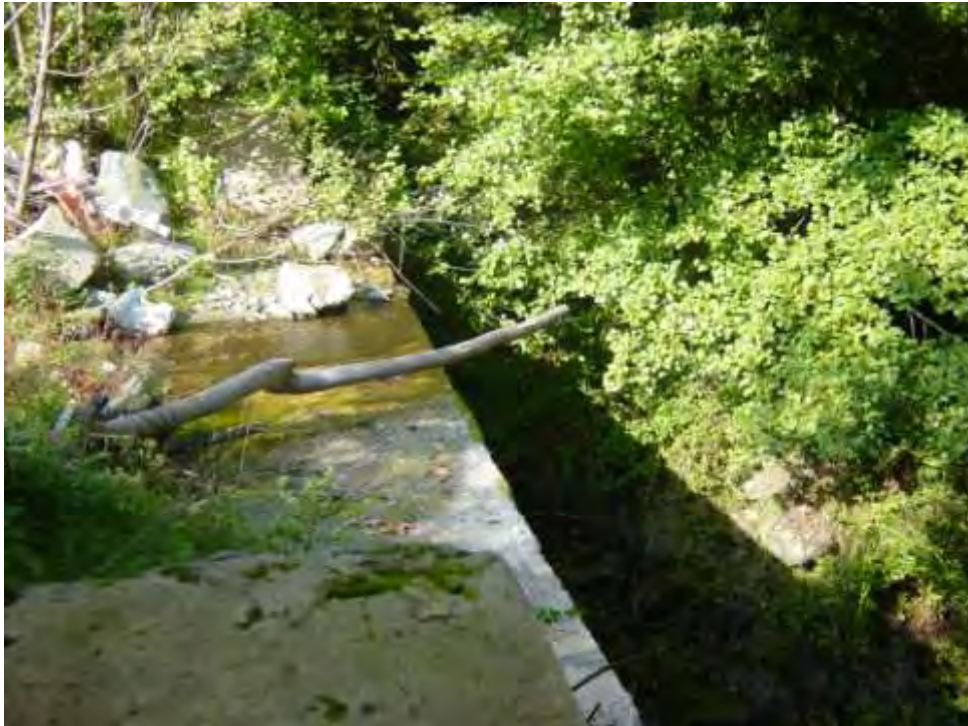
Εικόνα 92: Πάνω στο περύγιο του φράγματος Νο 12
