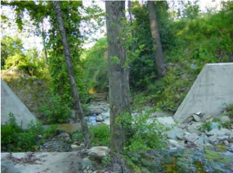
Εικόνα 78: Άναντη του φράγματος και προφράγματος Νο 2
