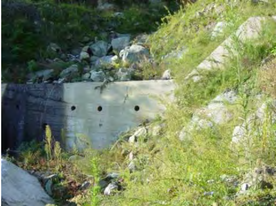
Εικόνα 90: Κατάντη του φράγματος Νο 9
