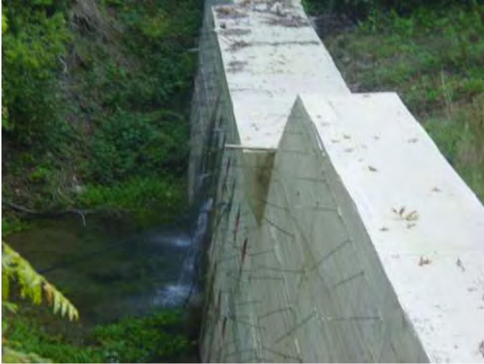
Εικόνα 102: Κατάντη του φράγματος Νο 16
