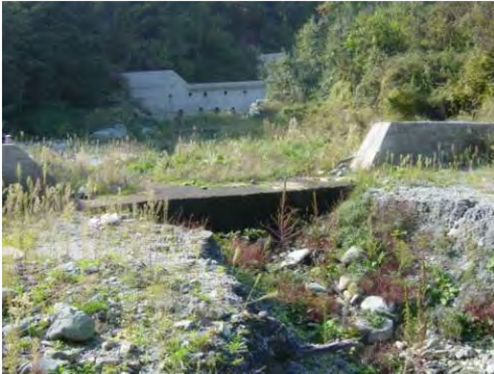
Εικόνα 94: Κατάντη των φραγμάτων Νο 13, 14, 15
