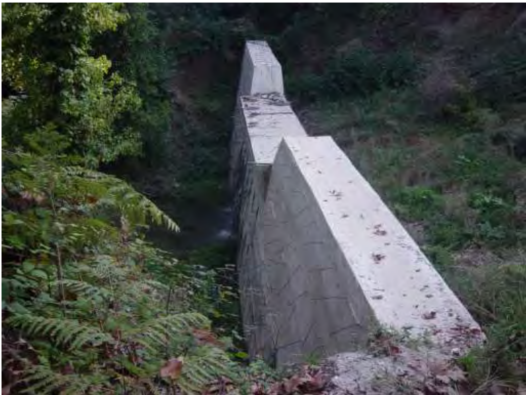
Εικόνα 103: Κατάντη του φράγματος Νο 16
