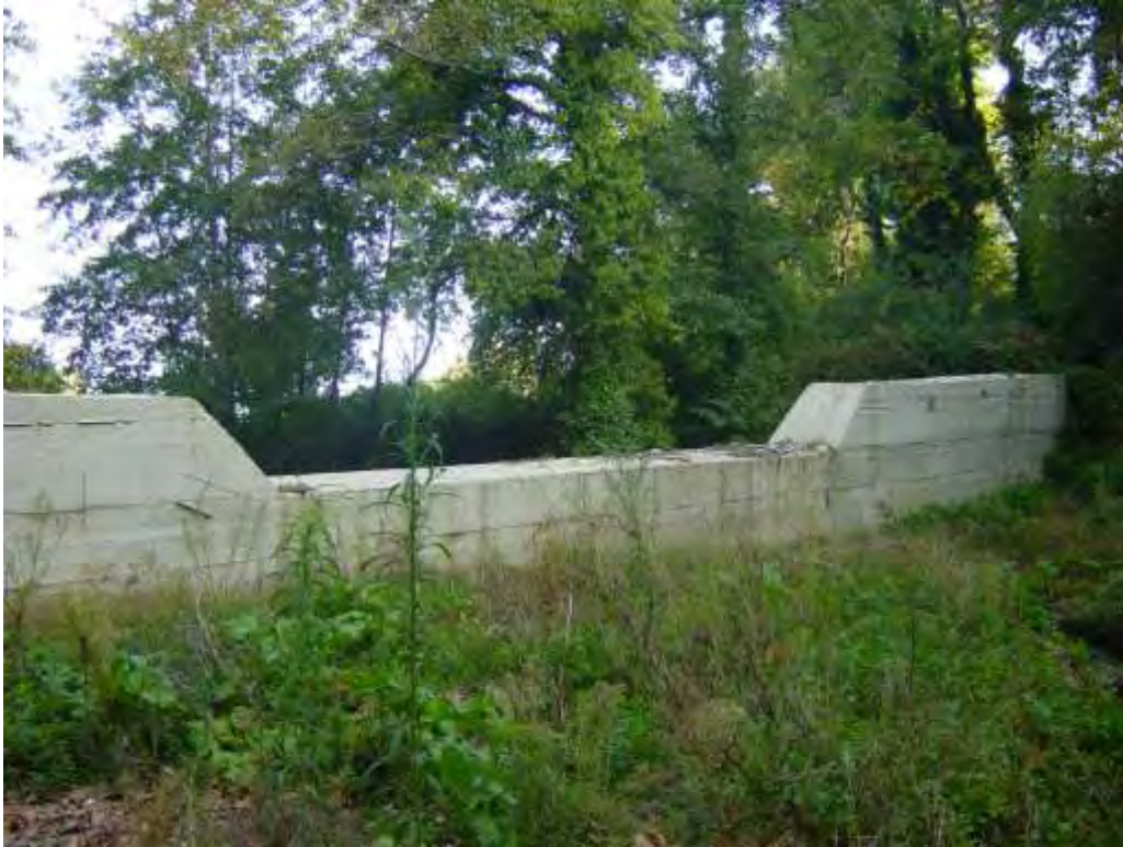
Εικόνα 104: Ανάντη του φράγματος Νο 16
