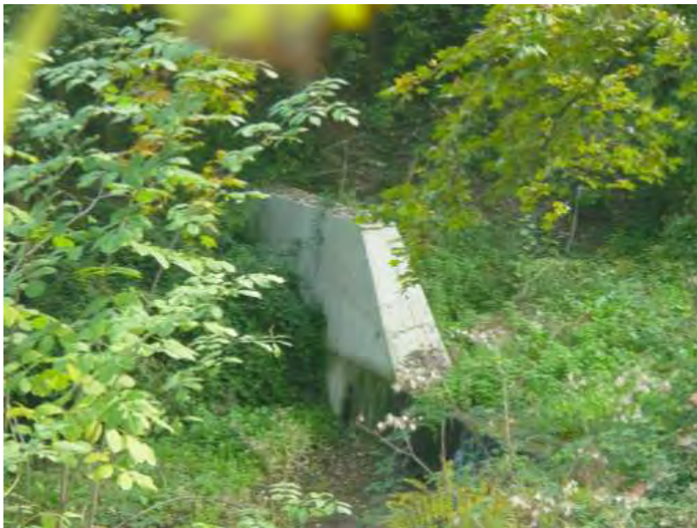
Εικόνα 101: Κατάντη του προφράγματος Νο 16
