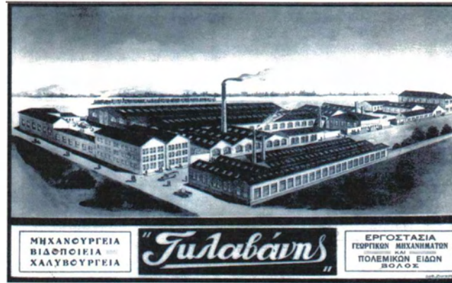
Εργοστάσιο Γκλαβάνη, Βόλος. Πλουραλιστικό κτίριο. Πηγή: Αρχείο Δ.Η.Κ.Ι.
