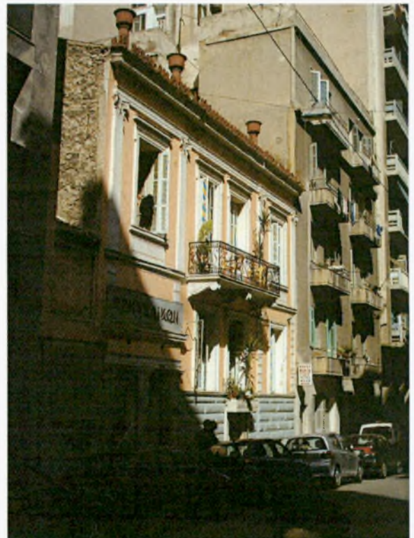
Φωτογραφία 18. Νεοκλασική κατοικία σε καλή κατάσταση.
