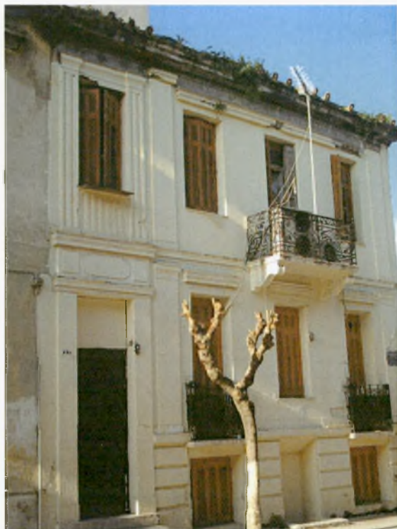
Φωτογραφία 2. Νεοκλασική κατοικία σε καλή κατάσταση.
