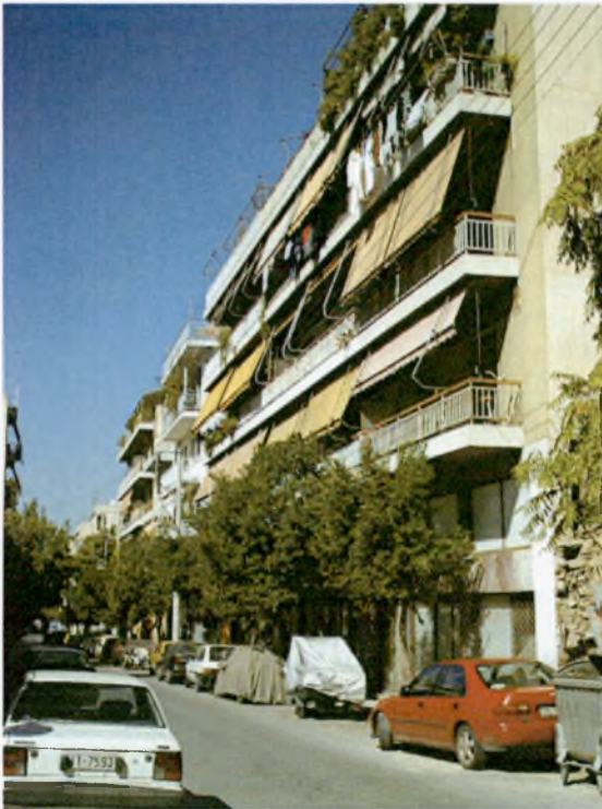
Φωτογραφία 24. Πολυκατοικία σε καλή κατάσταση.
