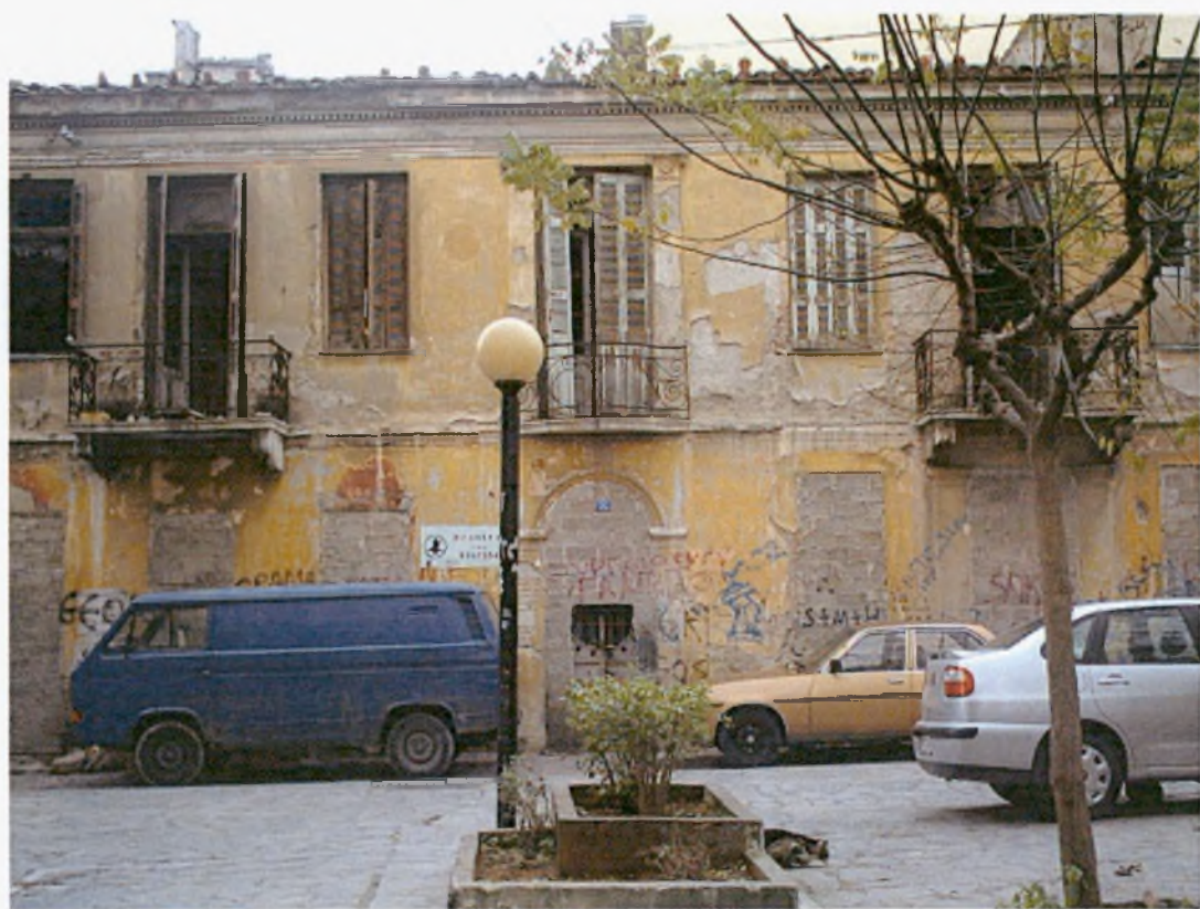
Φωτογραφία 6. Νεοκλασικές κατοικίες σε κακή κατάσταση.
