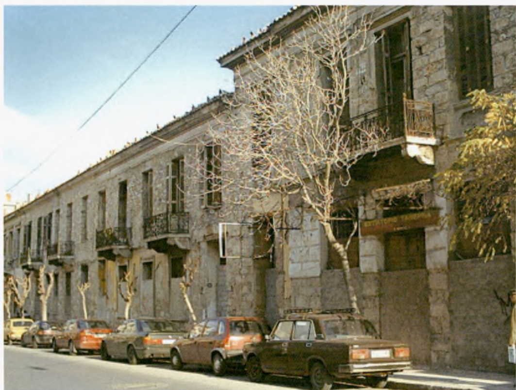
Φωτογραφία 5. Νεοκλασικές κατοικίες σε κακή κατάσταση.
