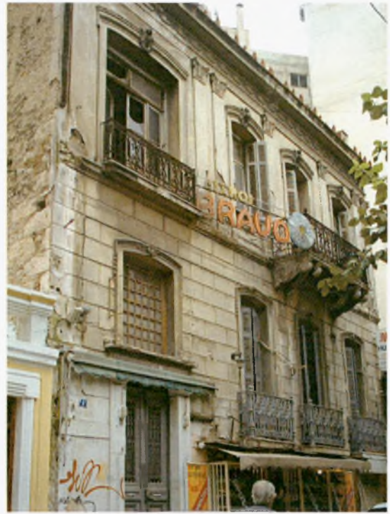
Φωτογραφία 12. Νεοκλασική κατοικία σε μέτρια κατάσταση.
