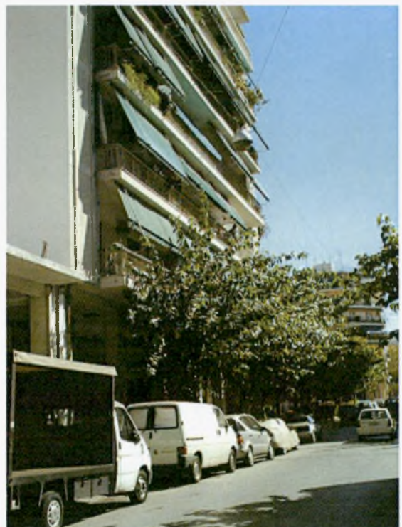
Φωτογραφία 25. Πολυκατοικία σε καλή κατάσταση.
