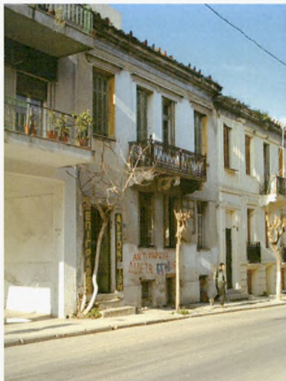
Φωτογραφία 3. Νεοκλασική κατοικία σε κακή κατάσταση.
