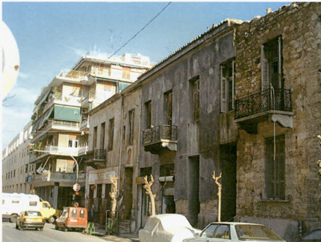
Φωτογραφία 4. Νεοκλασικές κατοικίες σε κακή κατάσταση.
