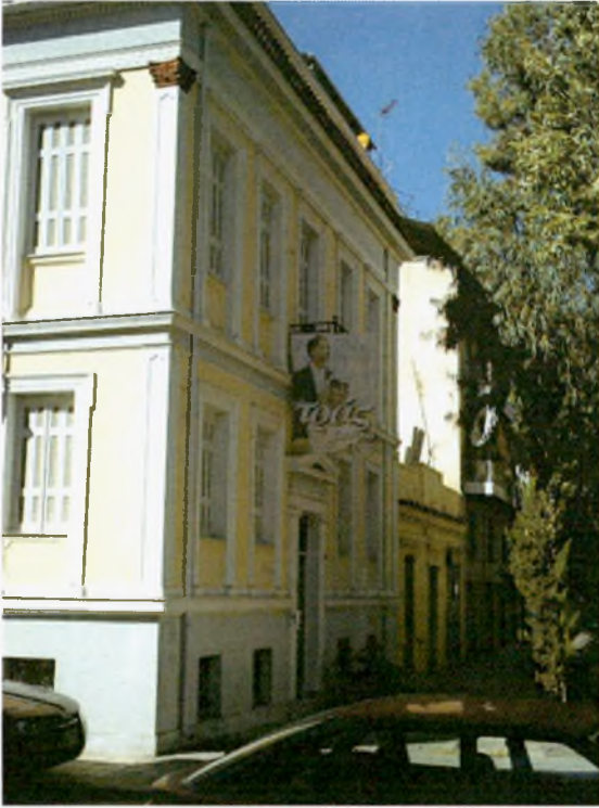
Φωτογραφία 22. Νεοκλασική κατοικία σε καλή κατάσταση.
