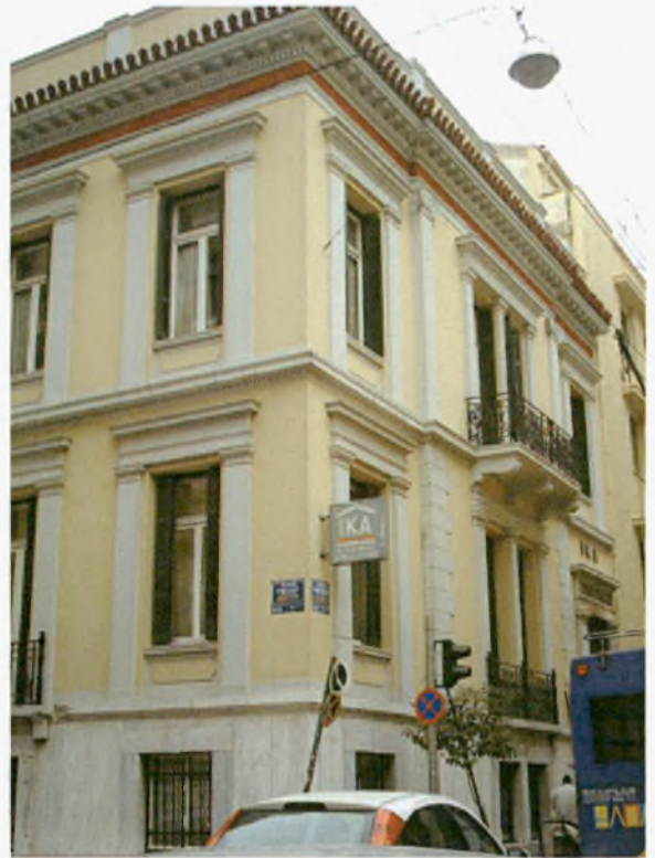
Φωτογραφία 16. Νεοκλασική κατοικία σε καλή κατάσταση.
