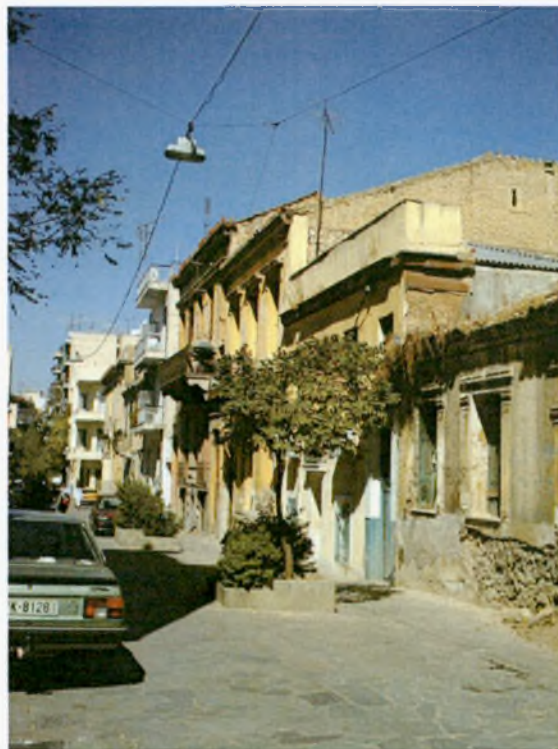
Φωτογραφία 20. Κατοικίες σε μέτρια κατάσταση.
