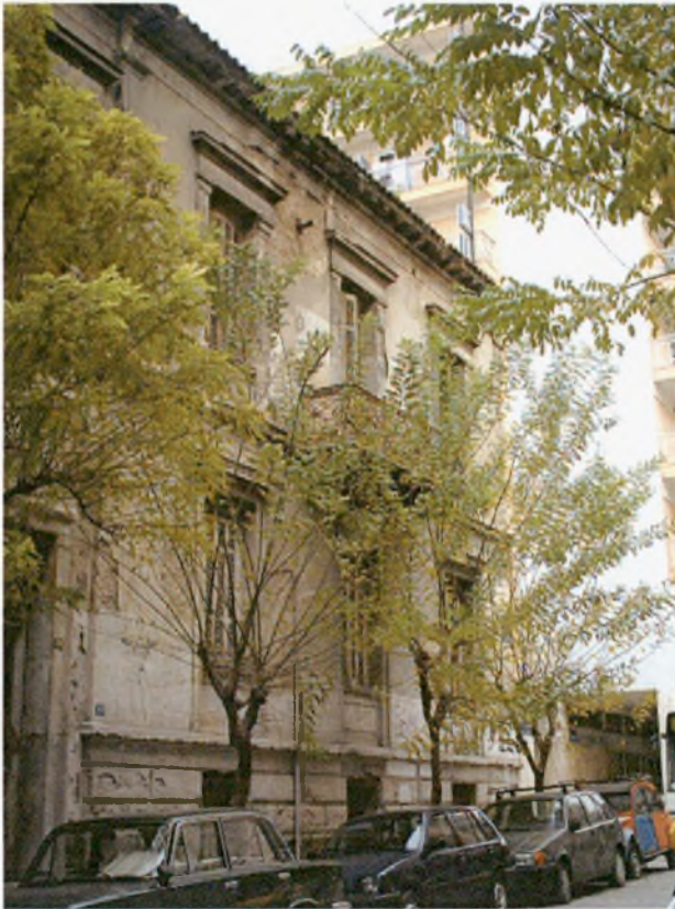
Φωτογραφία 8. Νεοκλασική κατοικία σε μέτρια κατάσταση.
