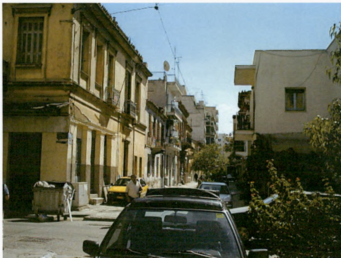
Φωτογραφία 21. Κατοικίες σε μέτρια κατάσταση.
