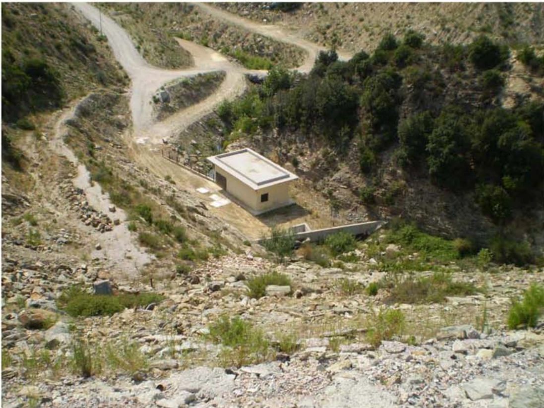
Εικόνα 21. Θέση κατασκευής Ταχυδιυλιστηρίων
