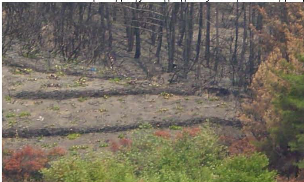
Εικόνα13. Τα αντιπλημμυρικά & αντιδιαβρωτικά έργα της λεκάνη απορροής του φράγματος Παναγιώτικο.
