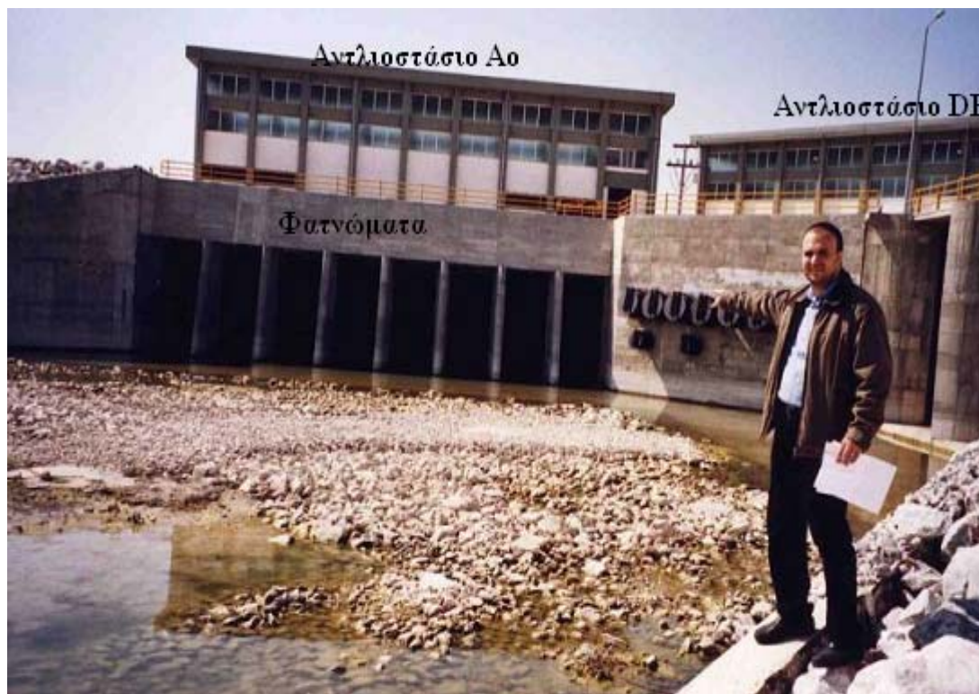
Εικόνα 64. Αντιπλημμυρικό-αποστραγγιστικό αντλιοστάσιο DP1 και άρδευσης Αο.
