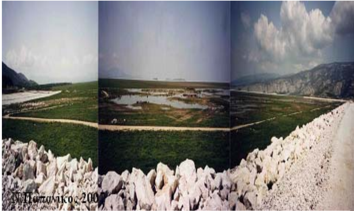
Εικόνα 61. Ο Ταμειυτήρας μετά την ολοκλήρωσή του.
