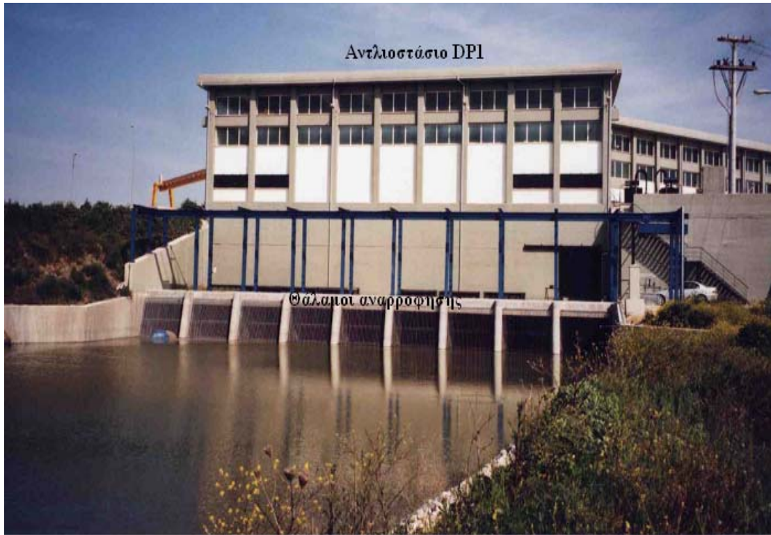
Εικόνα 66. Εξωτερική πλευρά του DP1, με τους 9 θαλάμους αναρρόφησης.
