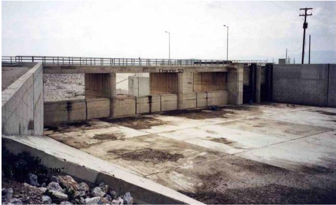
Εικόνα 73. Εξωτερική πλευρά του Συλλεκτήρα Σ3.
