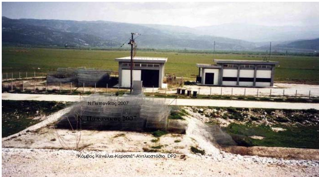
Εικόνα 71. Αντλιοστάσια αποχέτευσης -στράγγισης DP2 και άρδευσης A2.
