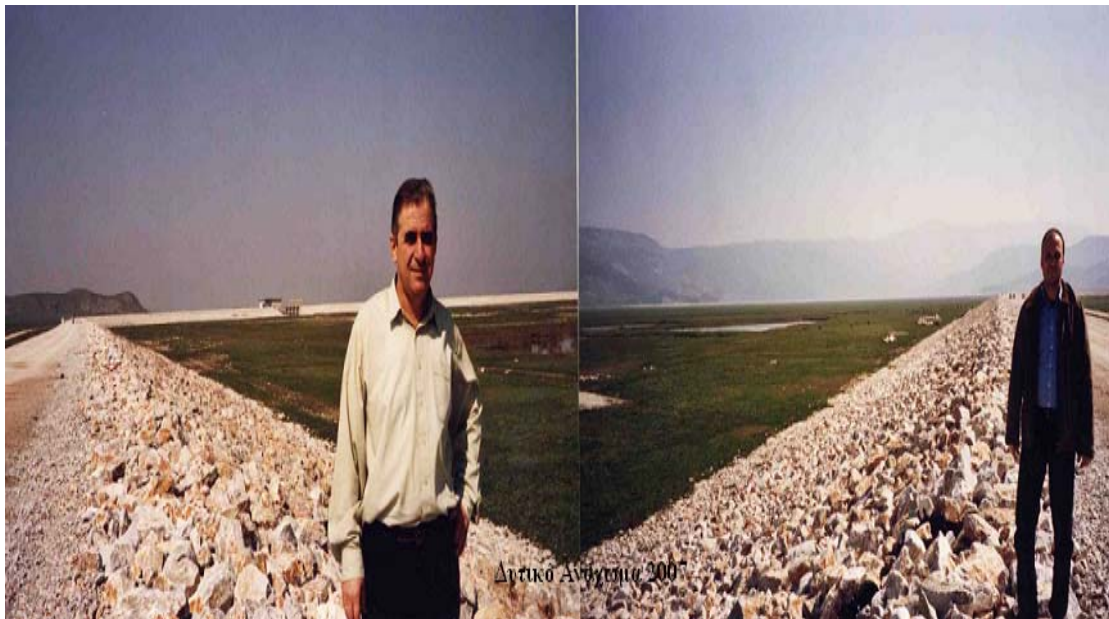
Εικόνα 56. Δυτικό ανάχωμα Ταμειυτήρα.
