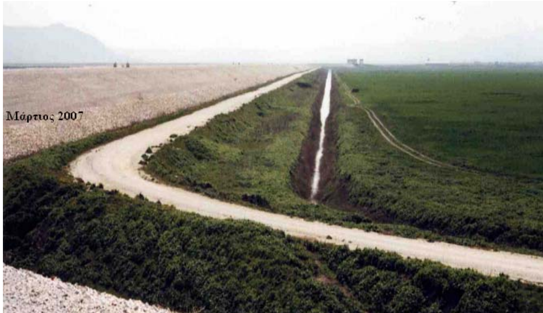
Εικόνα 59. Τάφρος για τον έλεγχο των διηθήσεων.
