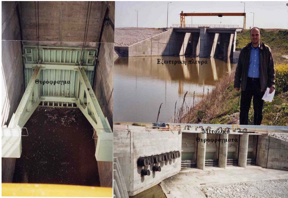
Εικόνα 65. Έργο Ασφαλείας Ταμιευτήρα
