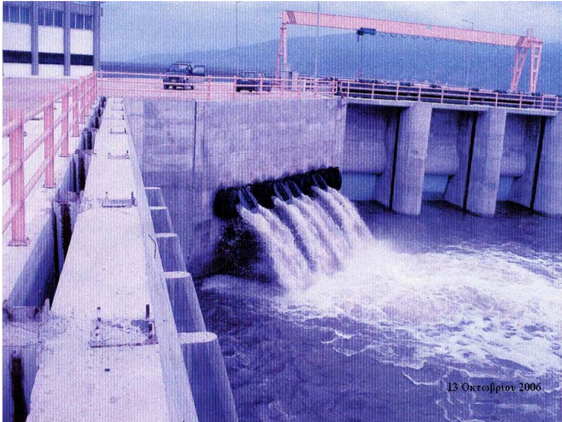
Εικόνα 68. Το Αντλιοστάσιο DP1 σε πλήρη λειτουργία.
