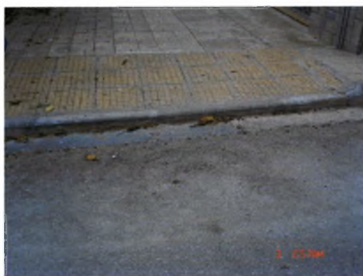
Εικόνα 36: Πρόσβαση στον πεζόδρομο που βρίσκεται το ασφαλιστικό ταμείο ΙΚΑ
