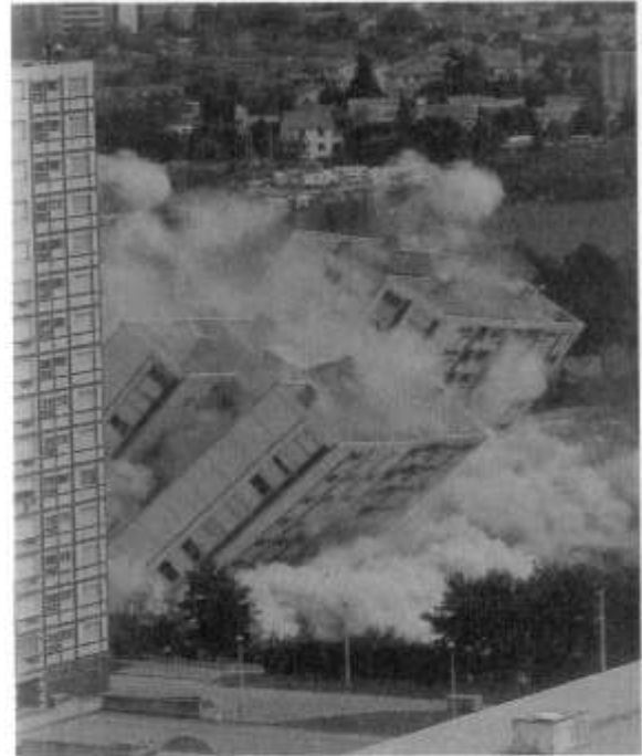
Εικόνα 1.2: Κατεδάφιση Συγκροτημάτων Οργανωμένης Δόμησης στη Γαλλία Πηγή: Herve Vieillard – Baron, 1996
