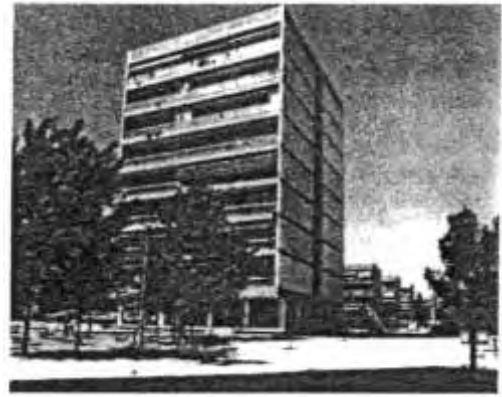
Εικόνα 1.6: 1η περίοδος: Πολυκατοικία οκτώ ορόφων στον οικισμό Μαρούσι 1. Πηγή: 40 χρόνια ΟΕΚ, Υπ. Εργασίας, 1994: 10
