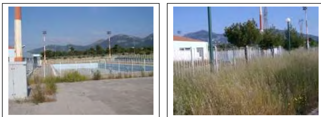
Εικόνες 7.4-7.5: Υπάρχουσα κατάσταση αθλητικών εγκαταστάσεων Ολυμπιακού Χωριού Πηγή: Διεθνές Διήμερο «Οι επιπτώσεις από τη διοργάνωση των Ολυμπιακών Αγώνων σε Πεκίνο, Αθήνα, Σύδνεϋ, Βαρκελώνη – Αξιοποίηση ολυμπιακών εγκαταστάσεων και έργων», ΤΕΕ, 7-8/05/2009, Αθήνα
