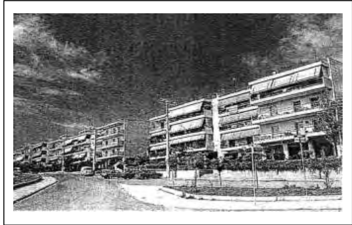
Εικόνα 2.11: 3η περίοδος: Οικισμός Μενίδι I (960 κατοικίες) Πηγή: 40 χρόνια ΟΕΚ, Υπ. Εργασίας, 1994: 13
