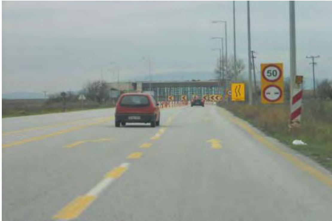
Εικόνα 4.7: Στη χ.θ. 8+270 είσοδος σε εργοταξιακή ζώνη
