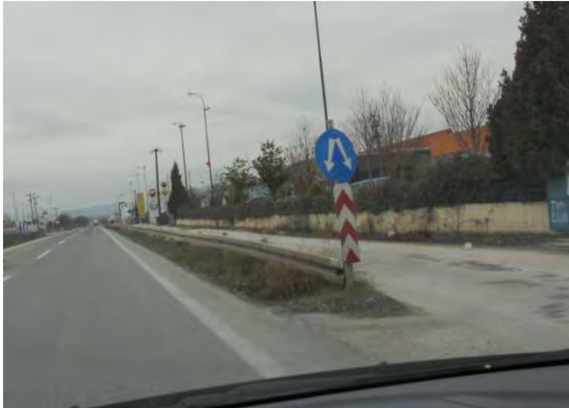
Εικόνα 4.3: Στη χ.θ. 1+800 ξεκινά παράπλευρη οδός για εξυπηρέτηση των βιομηχανιών
