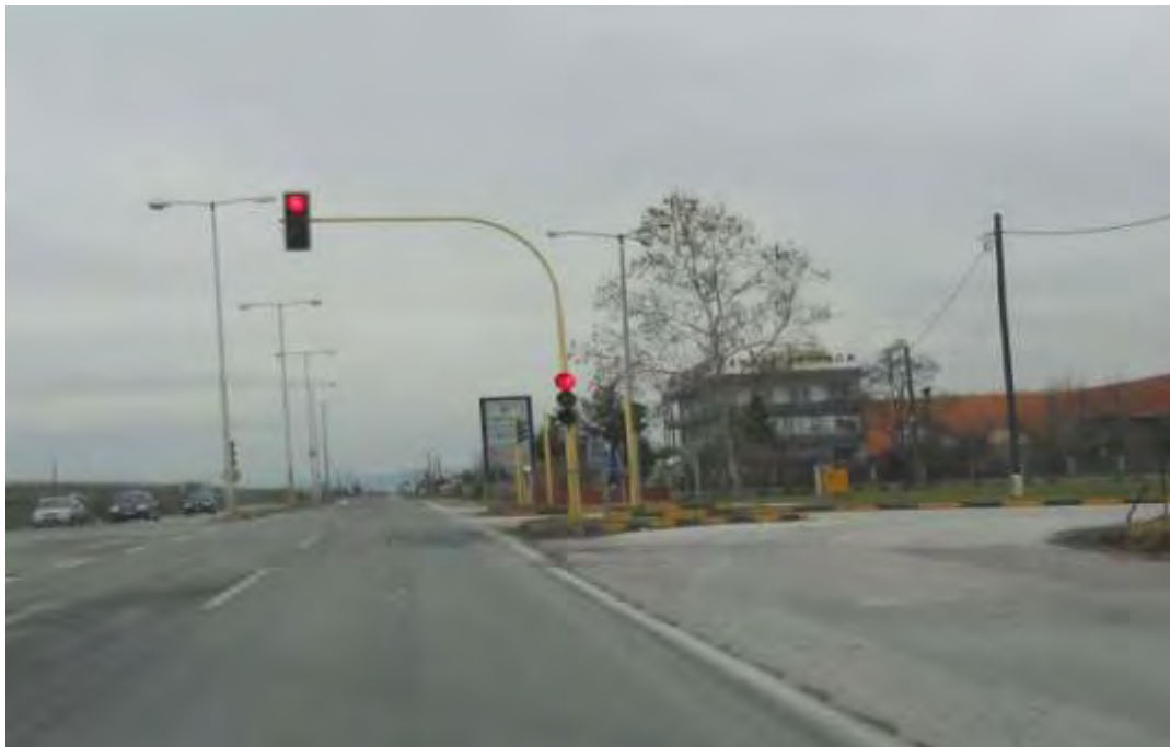
Εικόνα 4.4: Στη χ.θ. 2+500 ισόπεδος κόμβος με νησίδα
