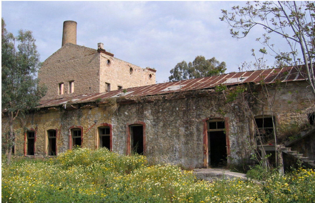
Η νότια πτέρυγα και ο πύργος διοίκησης με την καμινάδα στο βάθος
