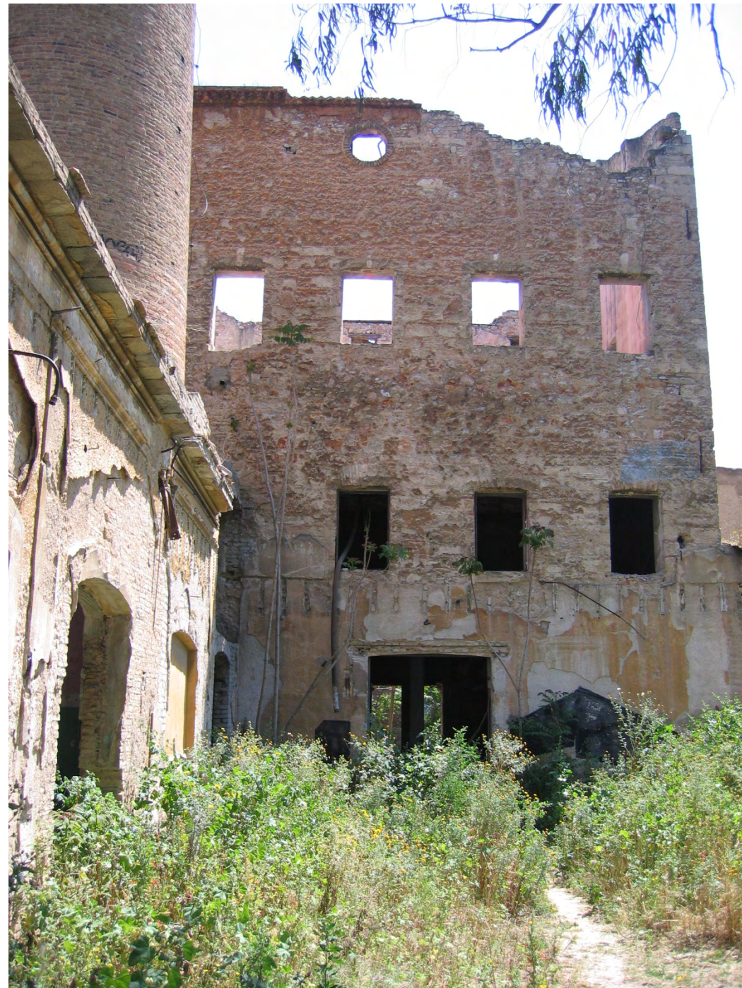
Η δυτική όψη του πύργου διοίκησης
