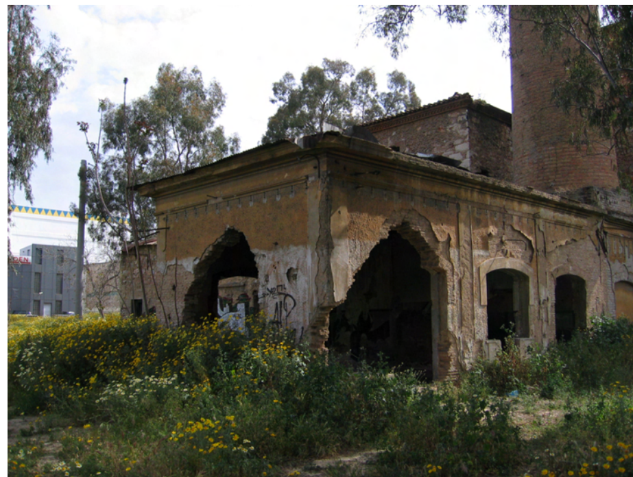
Η πλίνθινη πτέρυγα της καμινάδας
