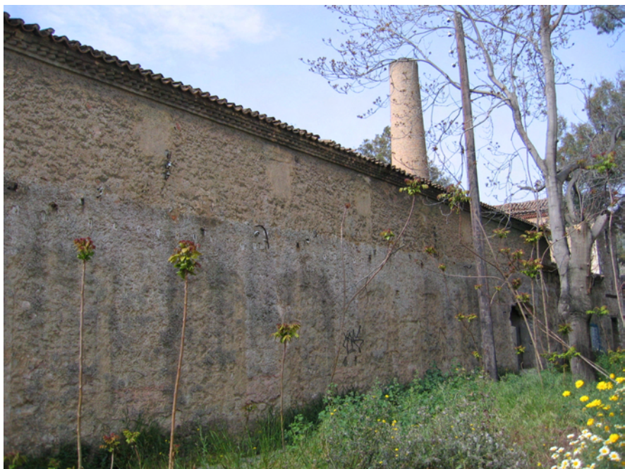
Η βόρεια πτέρυγα (χώρος αποθήκευσης) με χτιστά παράθυρα
