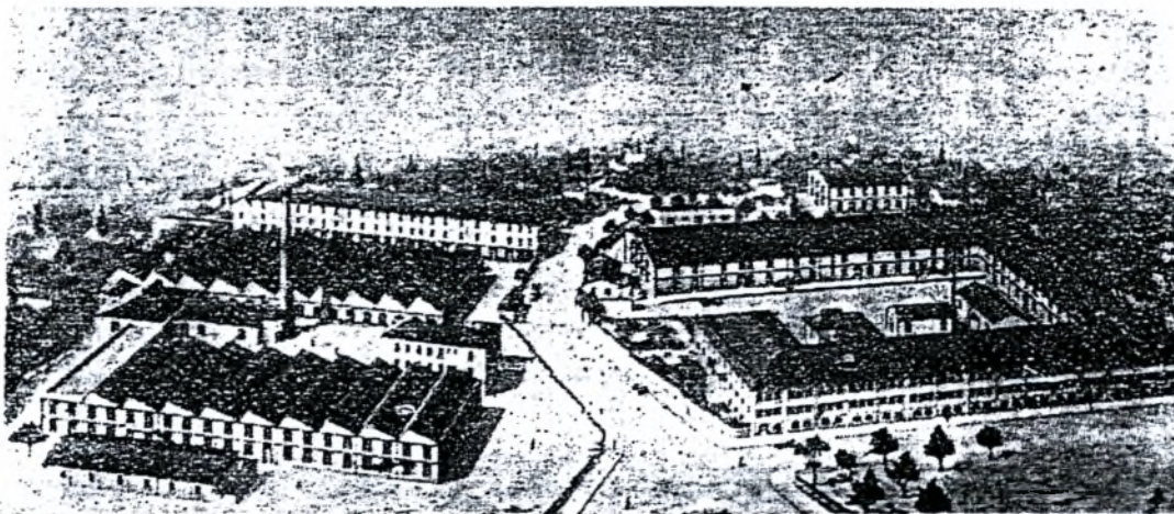
Εικ. 26. Οι εγκαταστάσεις των εργοστασίων Λαναρά στην περιοχή Κολοκυνθούς στην Αθήνα.
