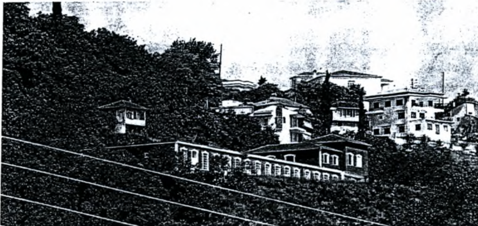
Εικ. 25. Το κτίριο του «Σχοινοποιείου», όπως είναι σήμερα.
